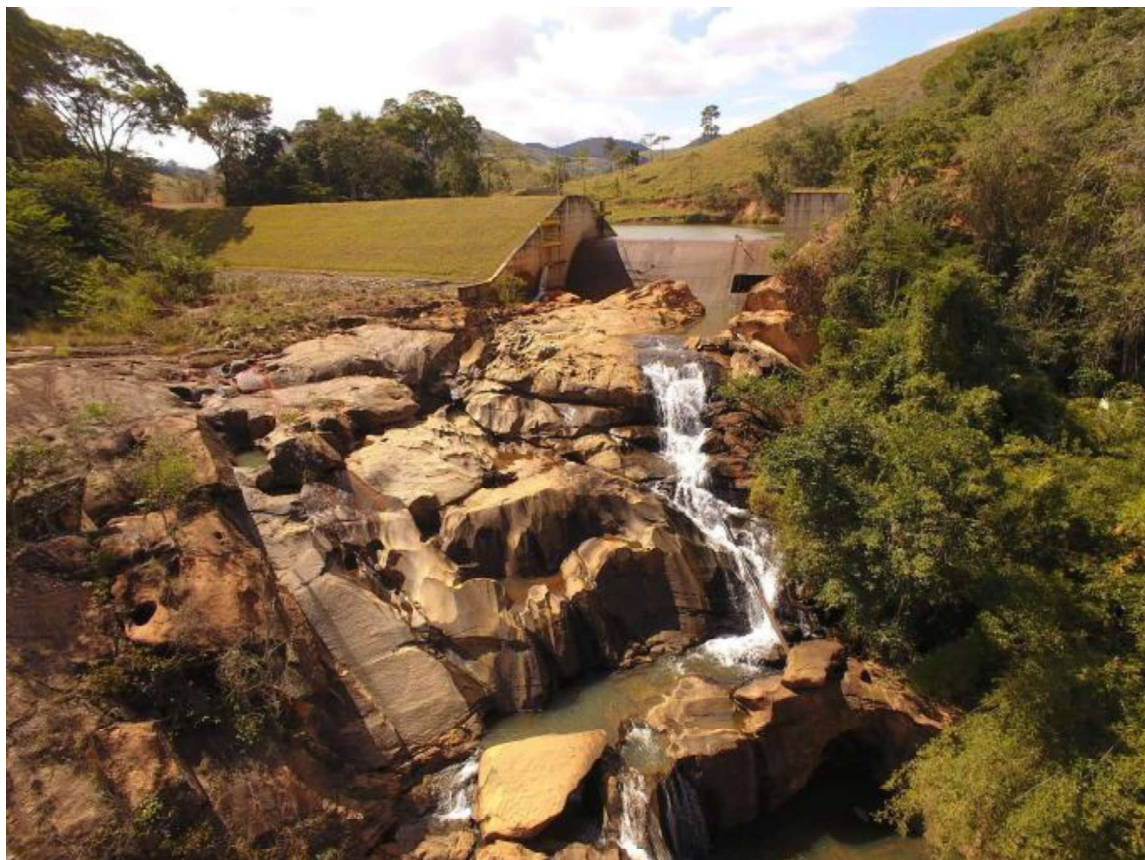
Figura 2. Vista geral da barragem da PCH Varginha
