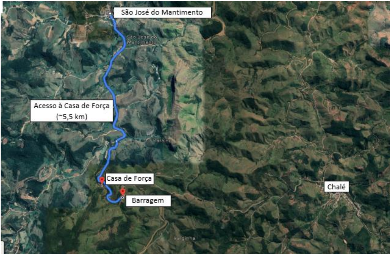
Figura 1. Acesso nas proximidades da PCH Varginha
