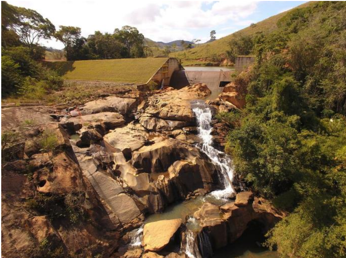
Figura 2. Vista geral da barragem da PCH Varginha
