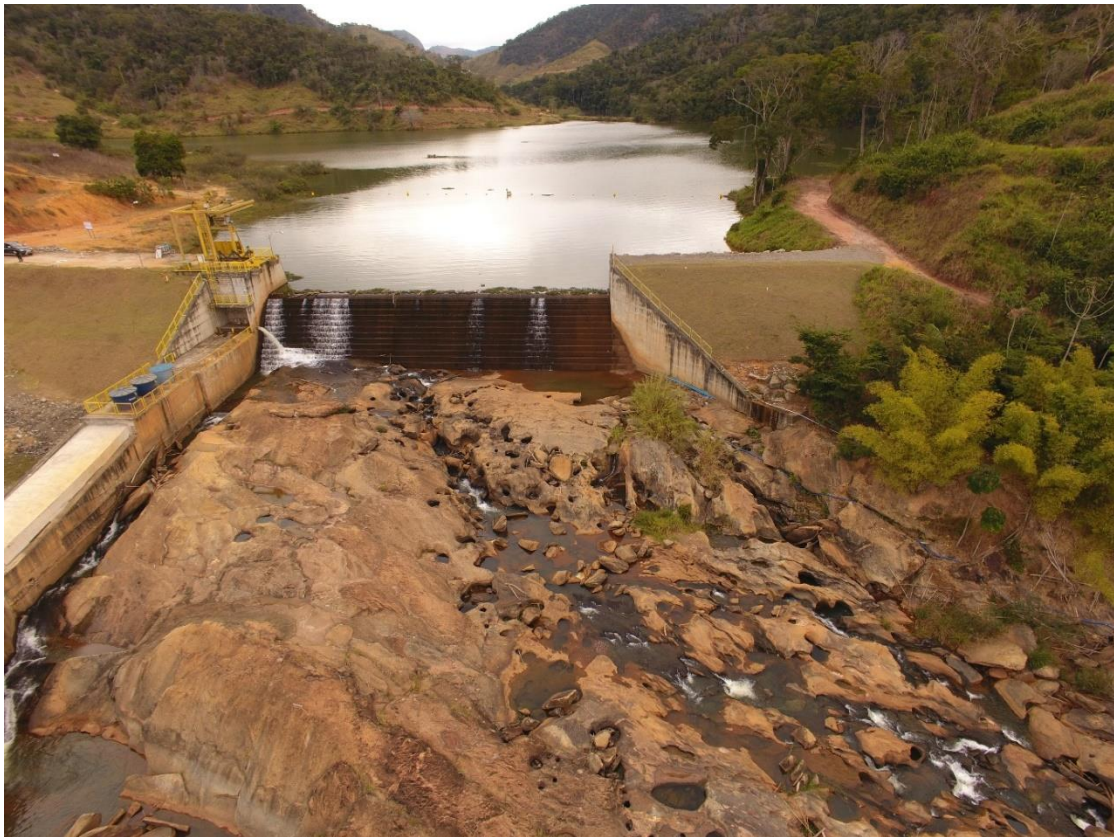
Figura 2. Vista geral da barragem da PCH Várzea Alegre
