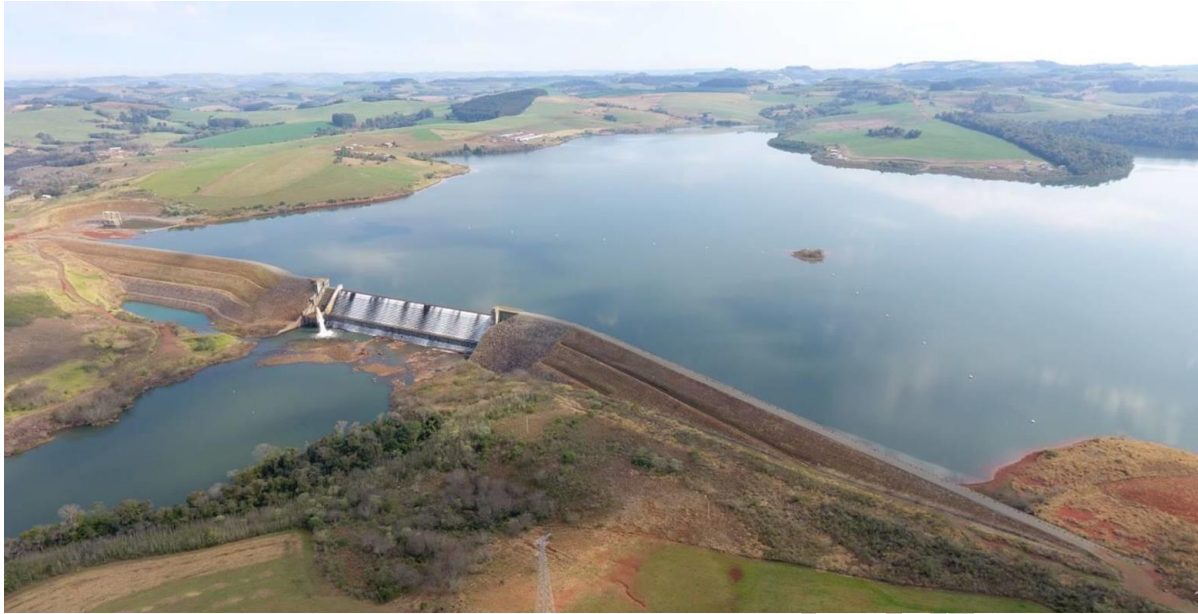
Figura 2. Vista geral da barragem da PCH Santa Luzia
