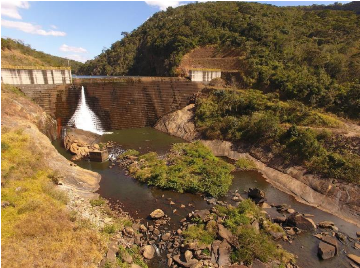
Figura 2. Vista geral da barragem da PCH São Gonçalo
