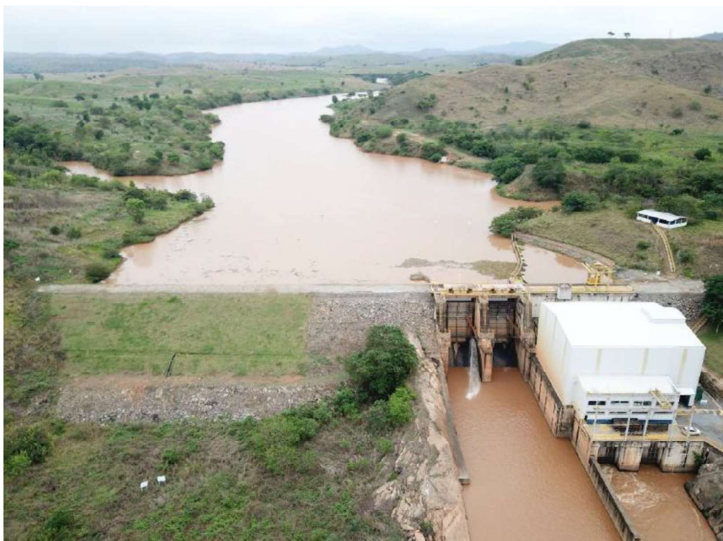
Figura 2. Vista geral da barragem da PCH Paiol
