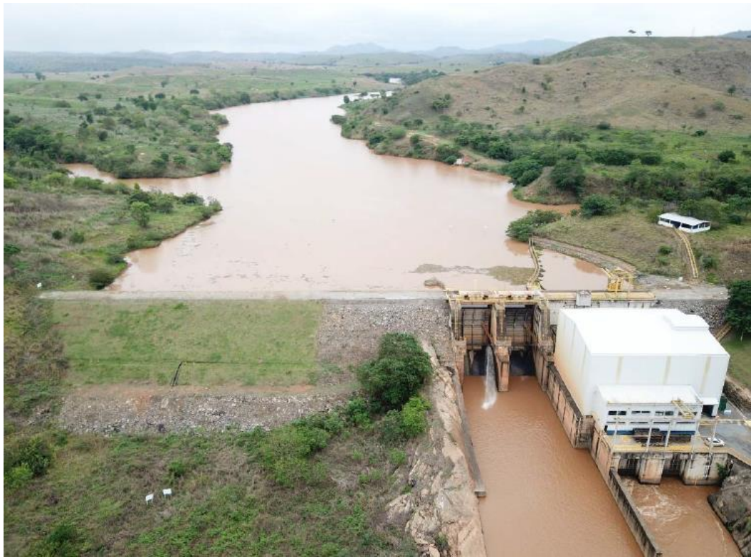
Figura 2. Vista geral da barragem da PCH Paiol
