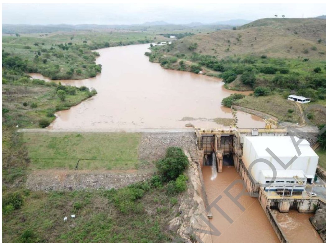
Figura 2. Vista geral da barragem da PCH Paiol
