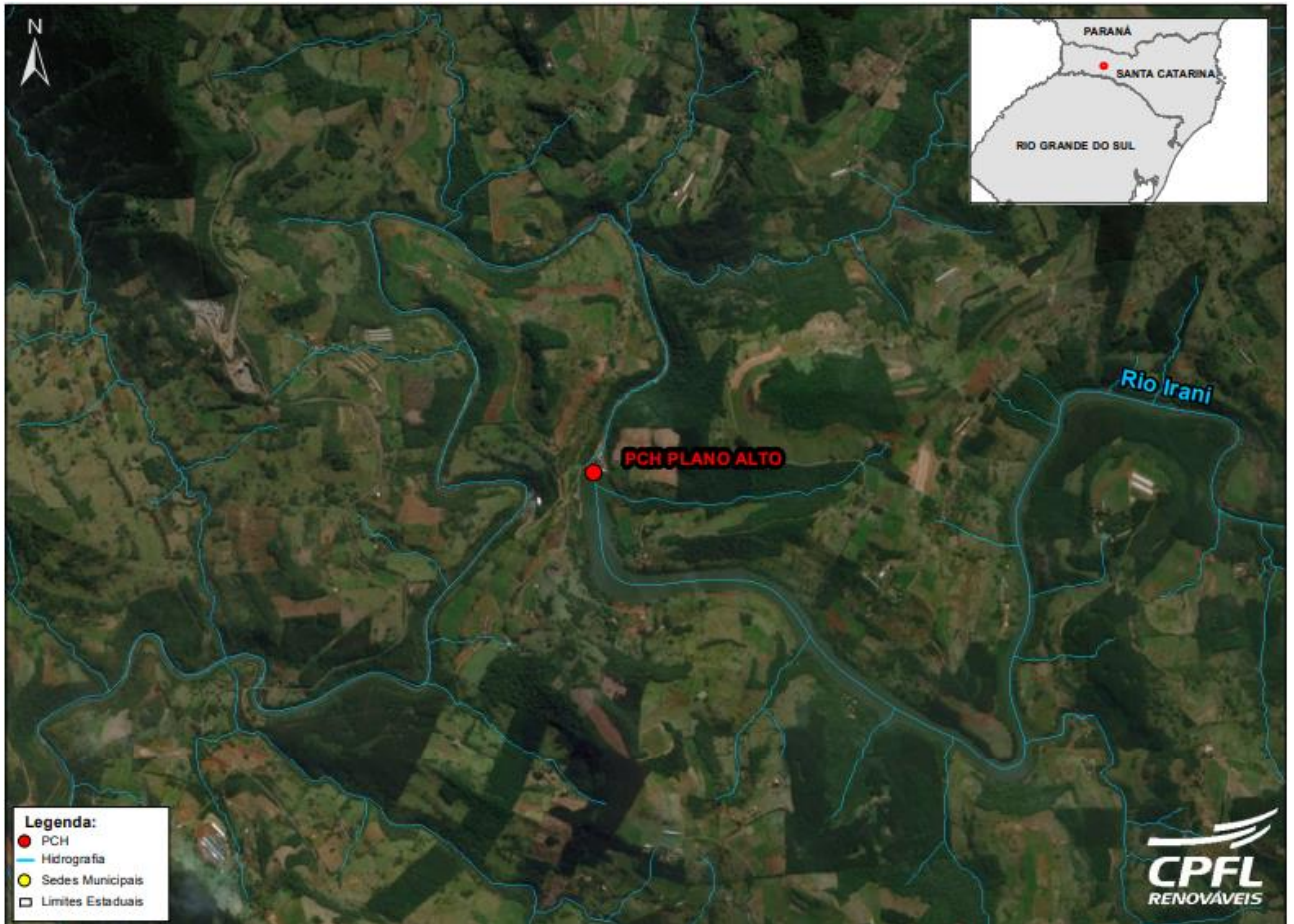
Figura 1. Acesso nas proximidades da PCH PLANO ALTO
