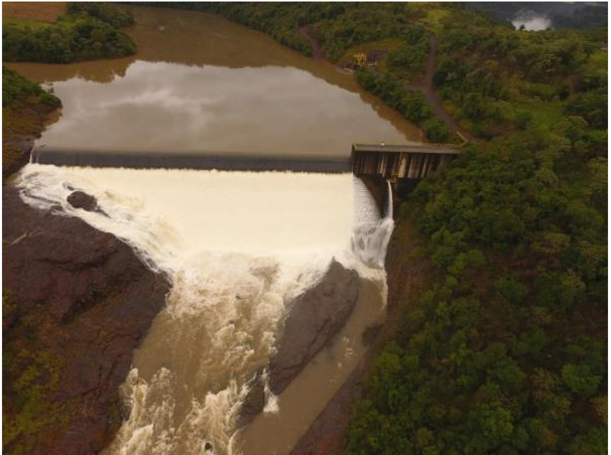
Figura 2. Vista geral da barragem da PCH Plano Alto
