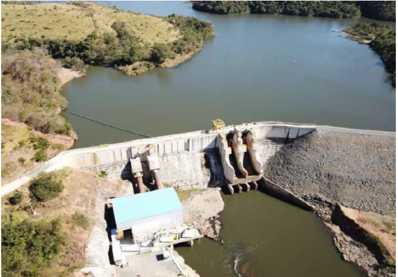
Figura 2. Vista geral da barragem da PCH Mata Velha
