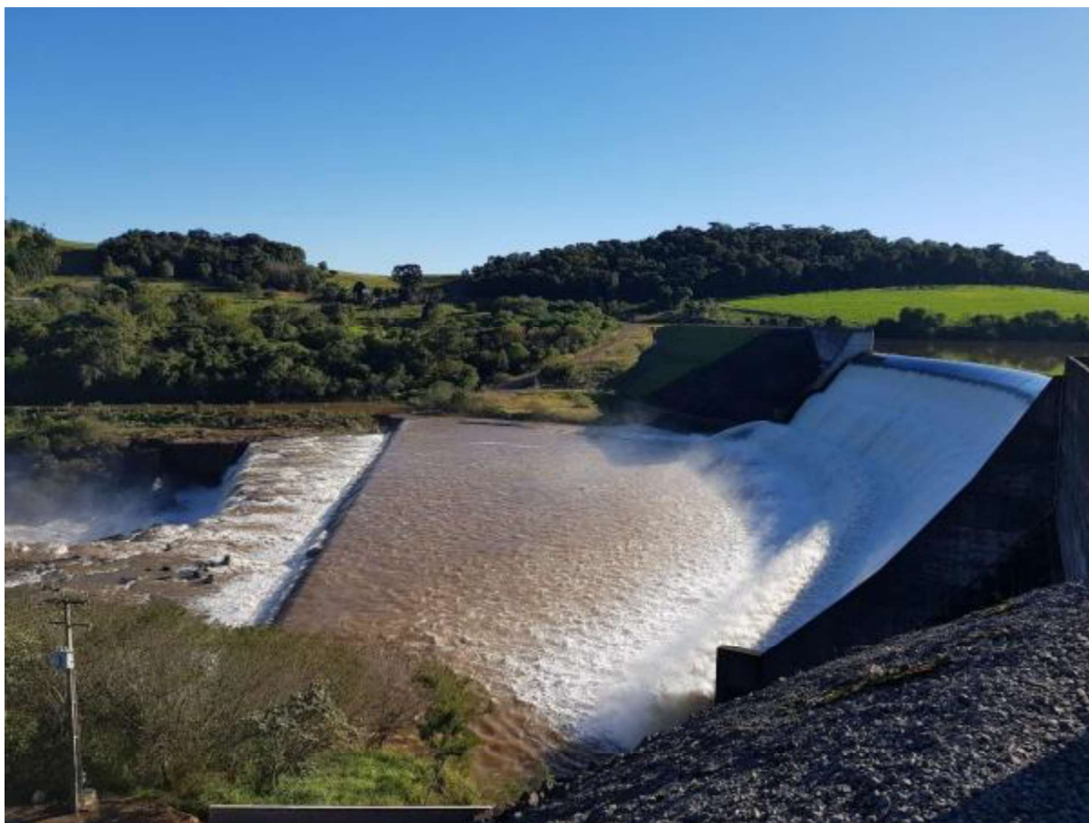
Figura 2. Vista geral da barragem da PCH Ludesa
