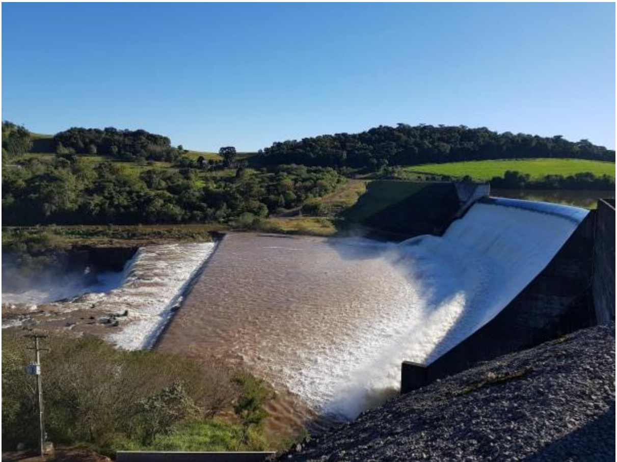
Figura 2. Vista geral da barragem da PCH Ludesa
