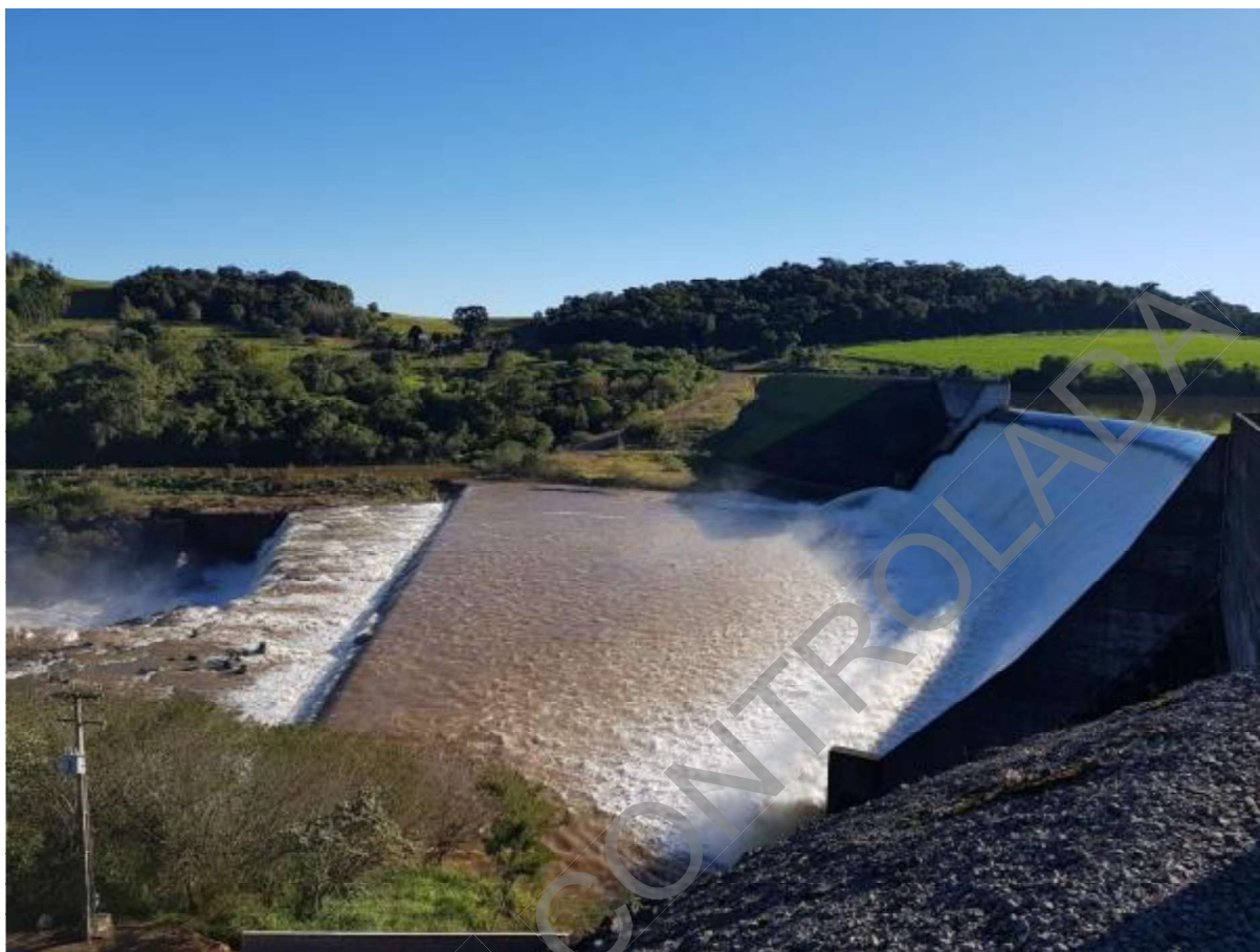
Figura 2. Vista geral da barragem da PCH Ludesa
