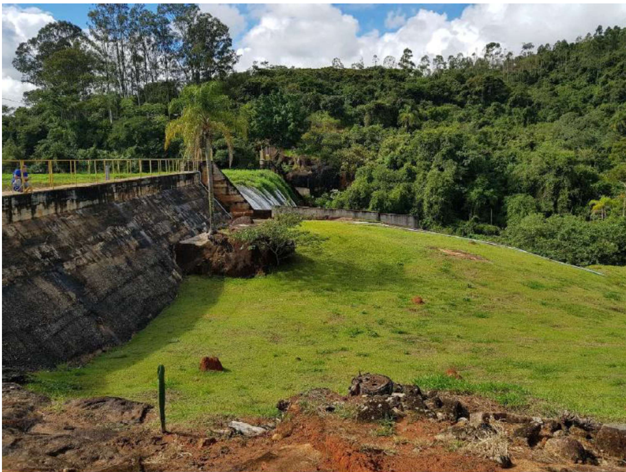
Figura 2. Vista geral da barragem da PCH Jaguari
