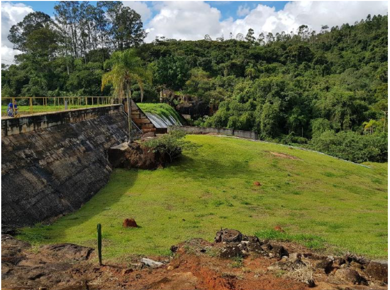
Figura 2. Vista geral da barragem da PCH Jaguari
