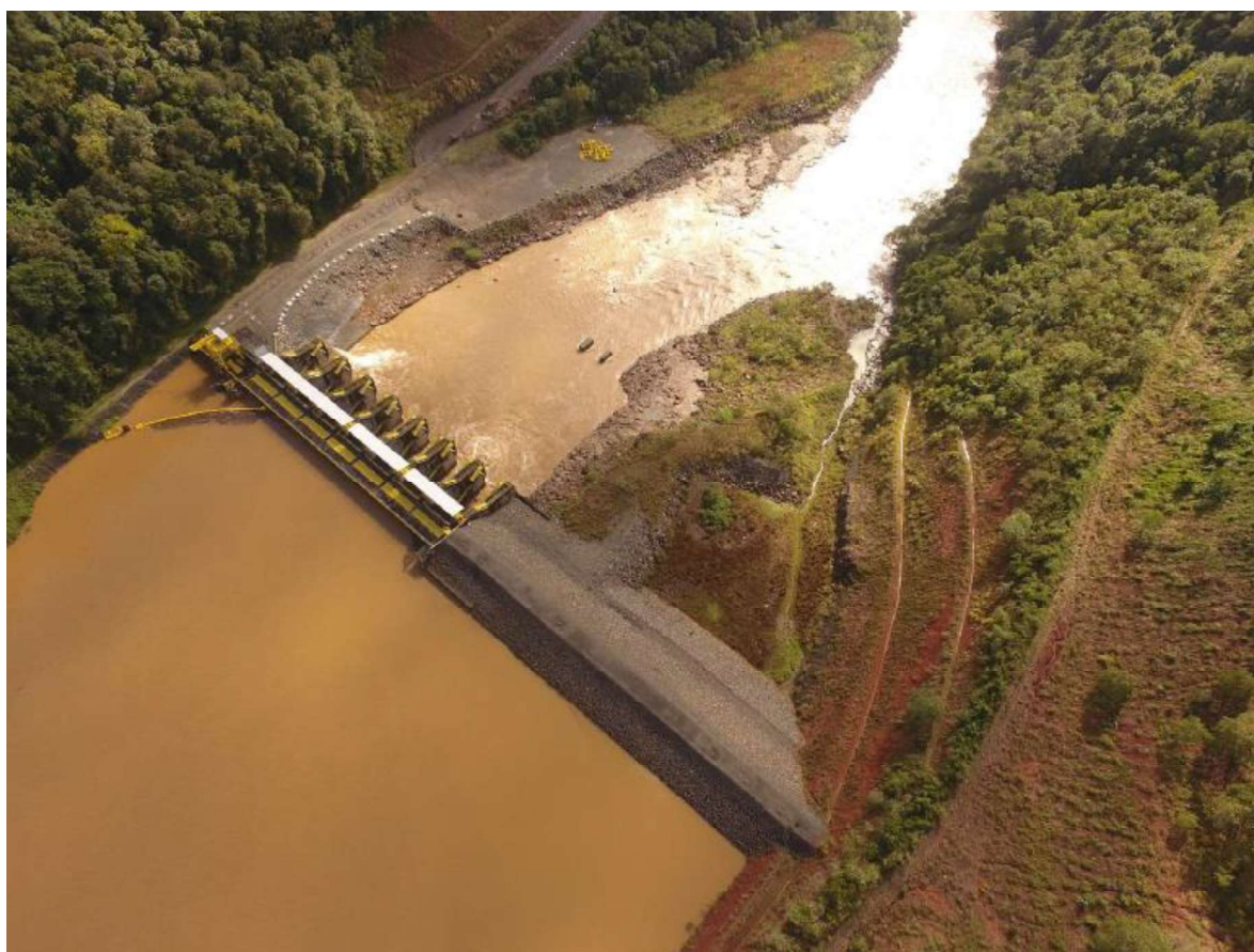
Figura 2. Vista geral da barragem da PCH Salto Góes
