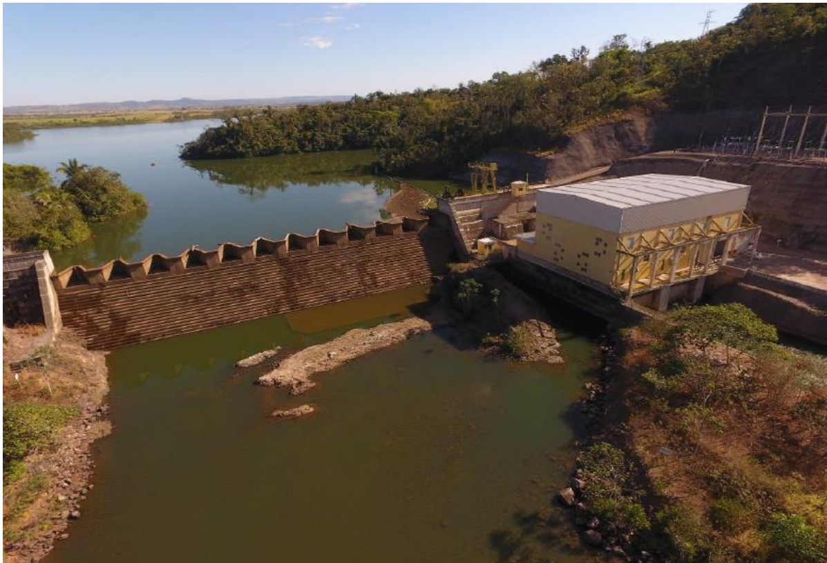
Figura 2. Vista geral da barragem da PCH Figueirópolis
