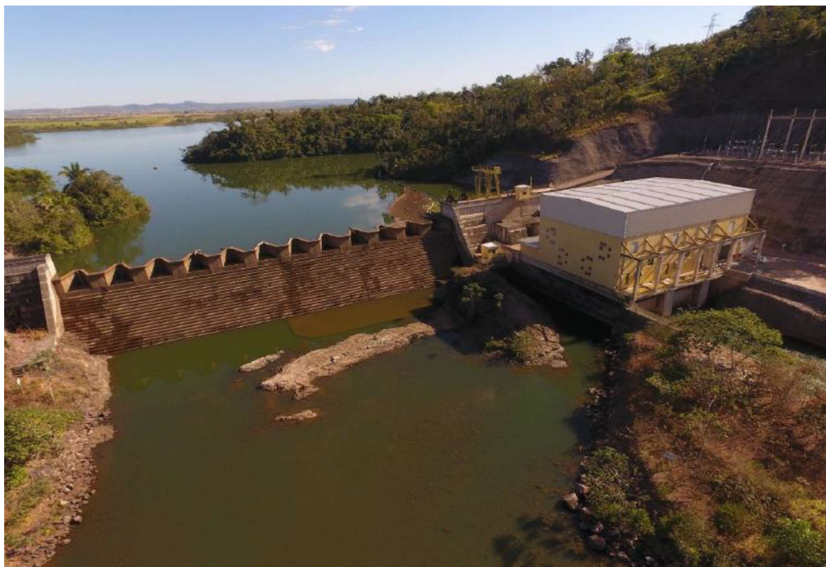
Figura 2. Vista geral da barragem da PCH Figueirópolis
