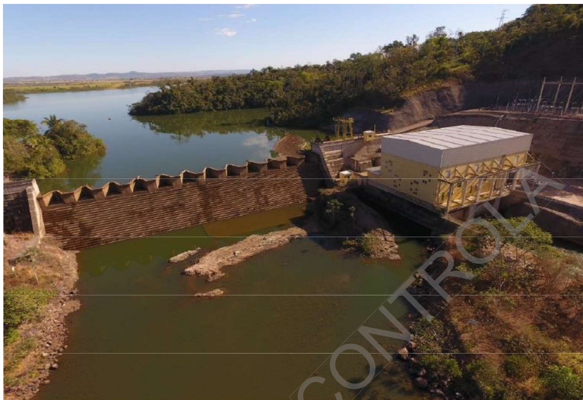
Figura 2. Vista geral da barragem da PCH Figueirópolis
