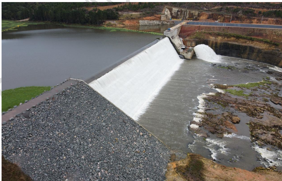
Figura 2. Vista geral da barragem da PCH Lúcia Cherobim
