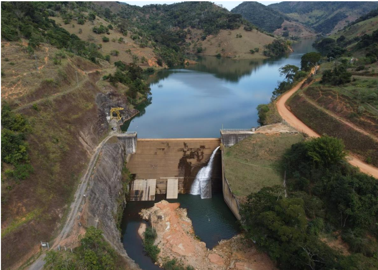
Figura 2. Vista geral da barragem da PCH Corrente Grande
