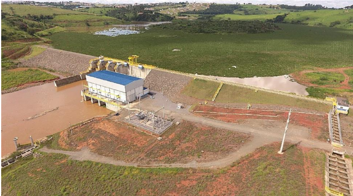
Figura 2. Vista geral da barragem da PCH BOA VISTA 2
