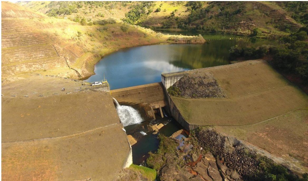
Figura 2. Vista geral da barragem da PCH Barra da Paciência
