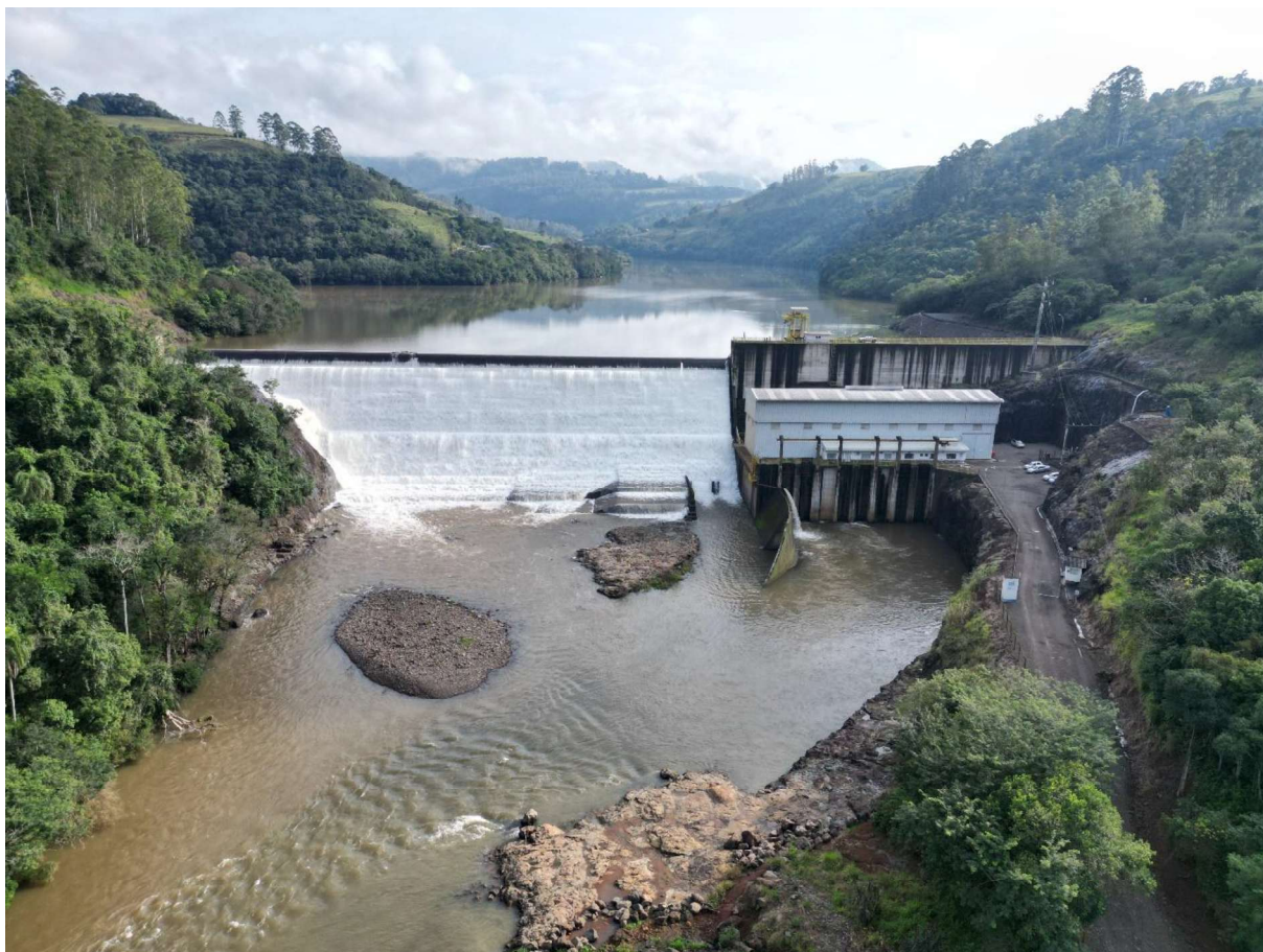
Figura 2. Vista geral da barragem da PCH Arvoredo
