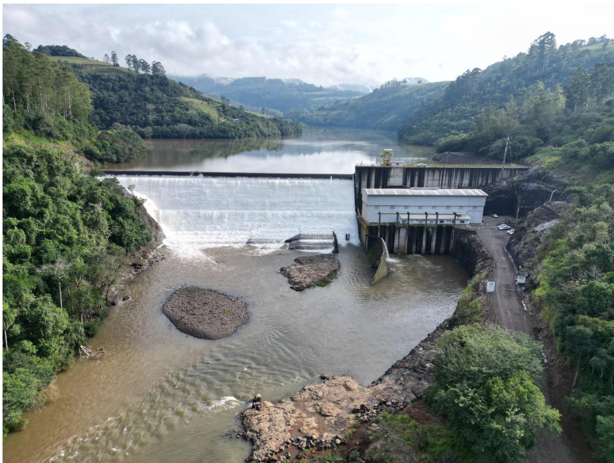
Figura 2. Vista geral da barragem da PCH Arvoredo
