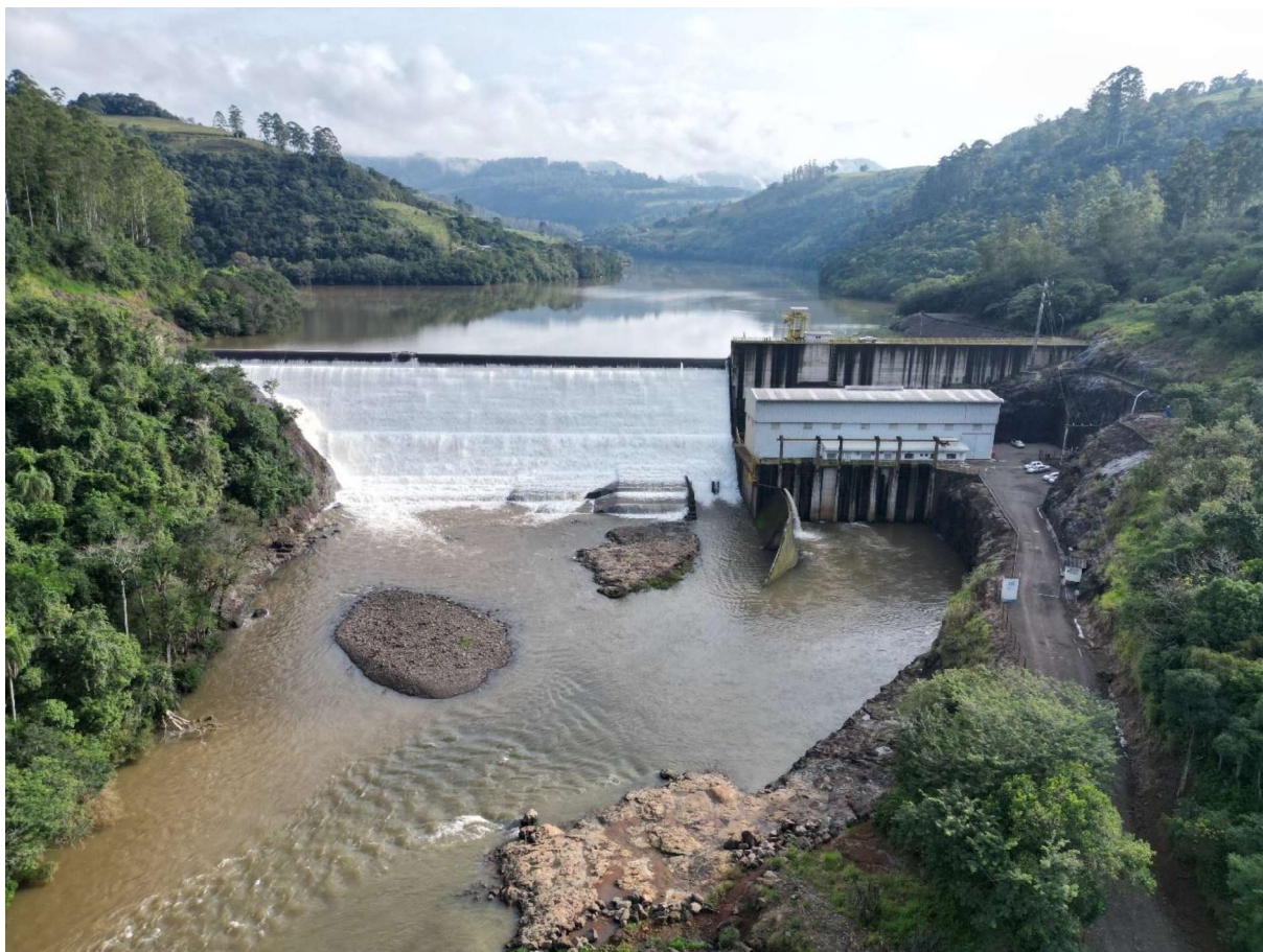
Figura 2. Vista geral da barragem da PCH Arvoredo
