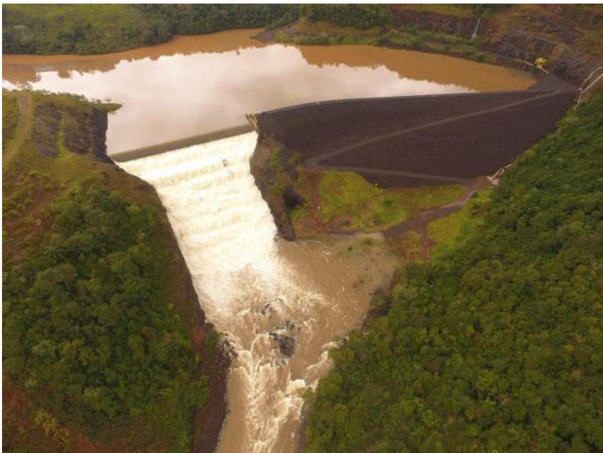
Figura 2. Vista geral da barragem da PCH Alto Irani
