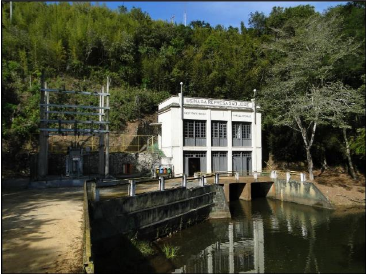
Figura 2. Vista geral da CGH São José
