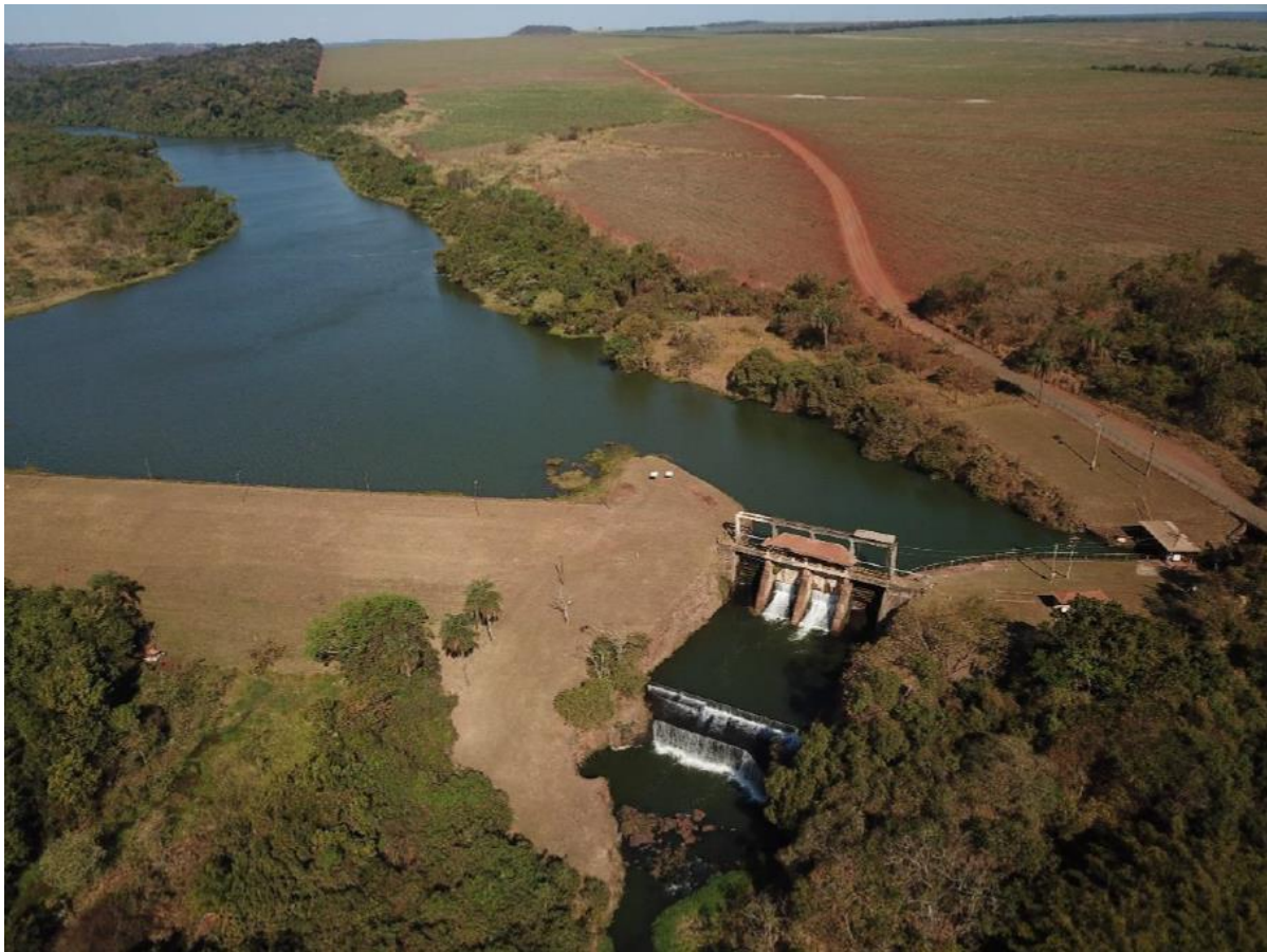
Figura 2. Vista geral da barragem da CGH Santana
