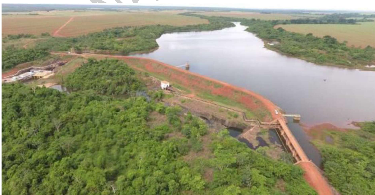
Figura 2. Vista geral da barragem da CGH Diamante
