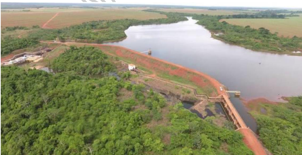
Figura 2. Vista geral da barragem da CGH Diamante
