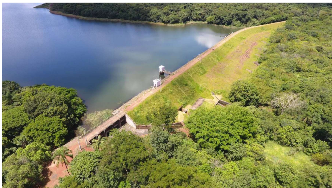
Figura 5. Barragem do Retiro
