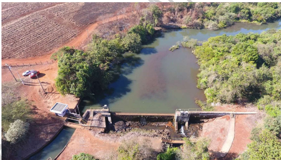
Figura 4. Vista geral da barragem do Alegria
