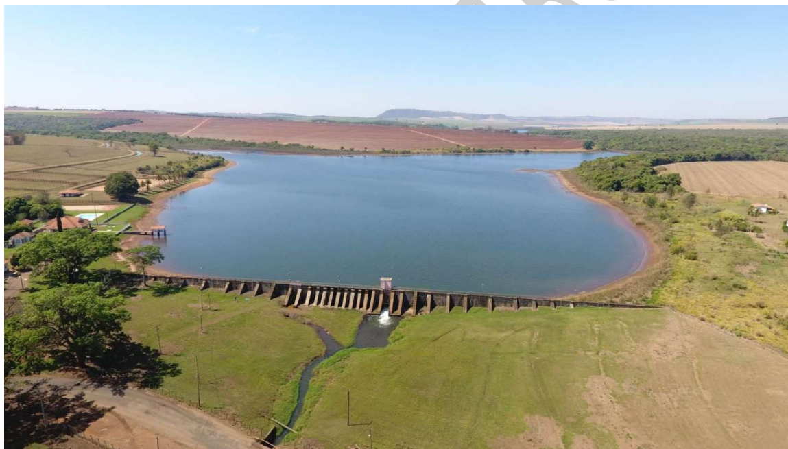
Figura 2. Vista geral da barragem da Barra
