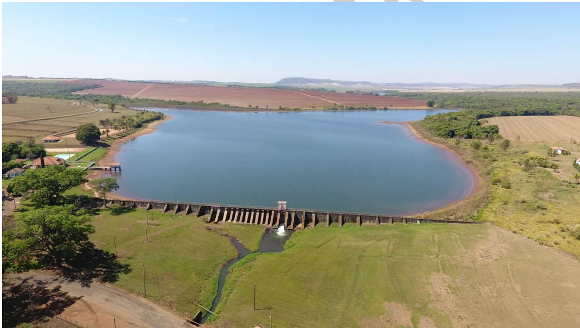
Figura 2. Vista geral da barragem da Barra
