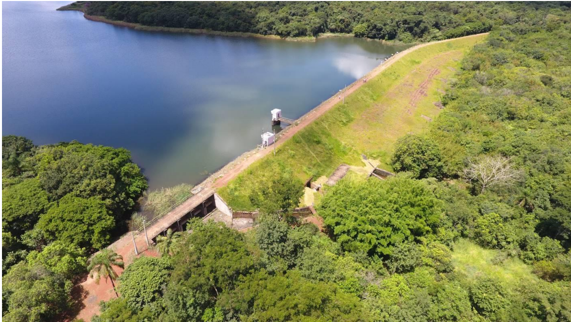
Figura 5. Barragem do Retiro
