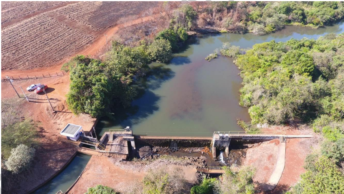
Figura 4. Vista geral da barragem do Alegria
