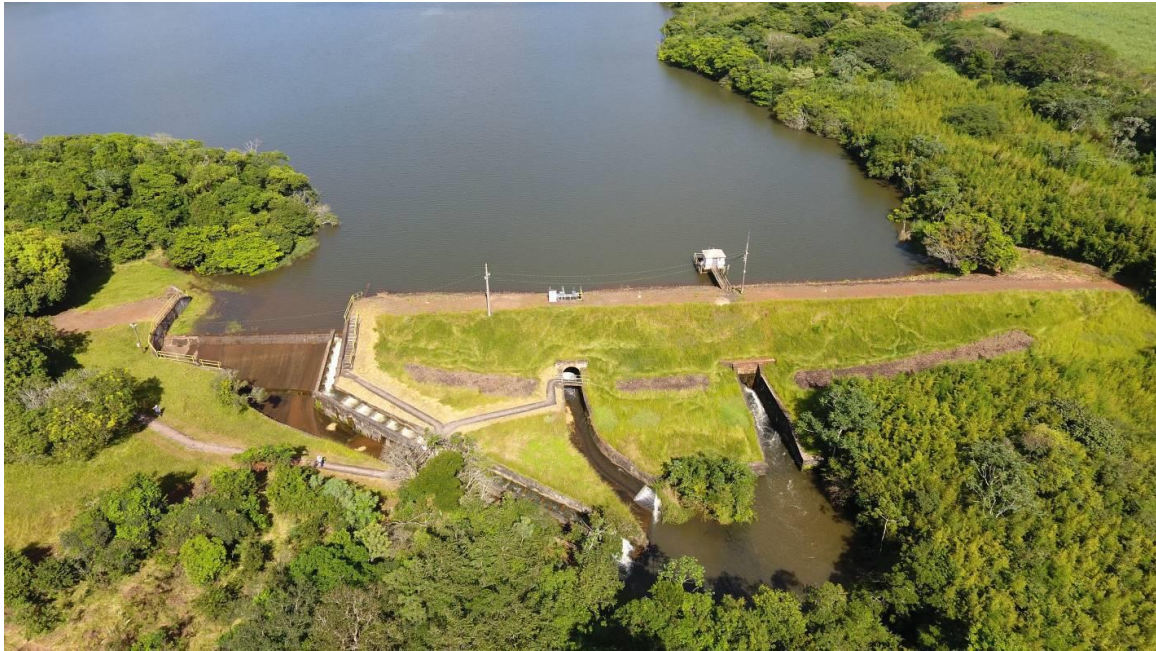
Figura 3. Vista geral da barragem do 29
