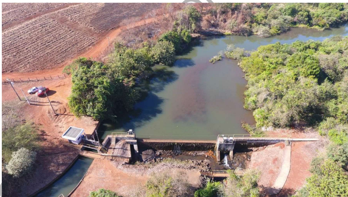
Figura 4. Vista geral da barragem do Alegria
