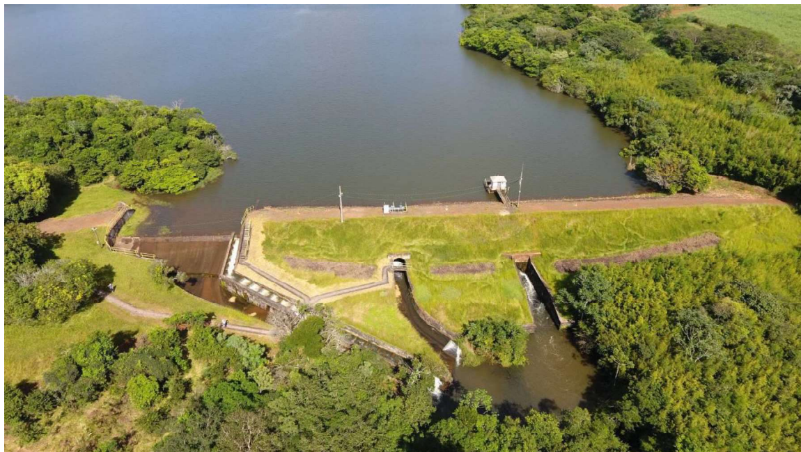
Figura 3. Vista geral da barragem do 29
