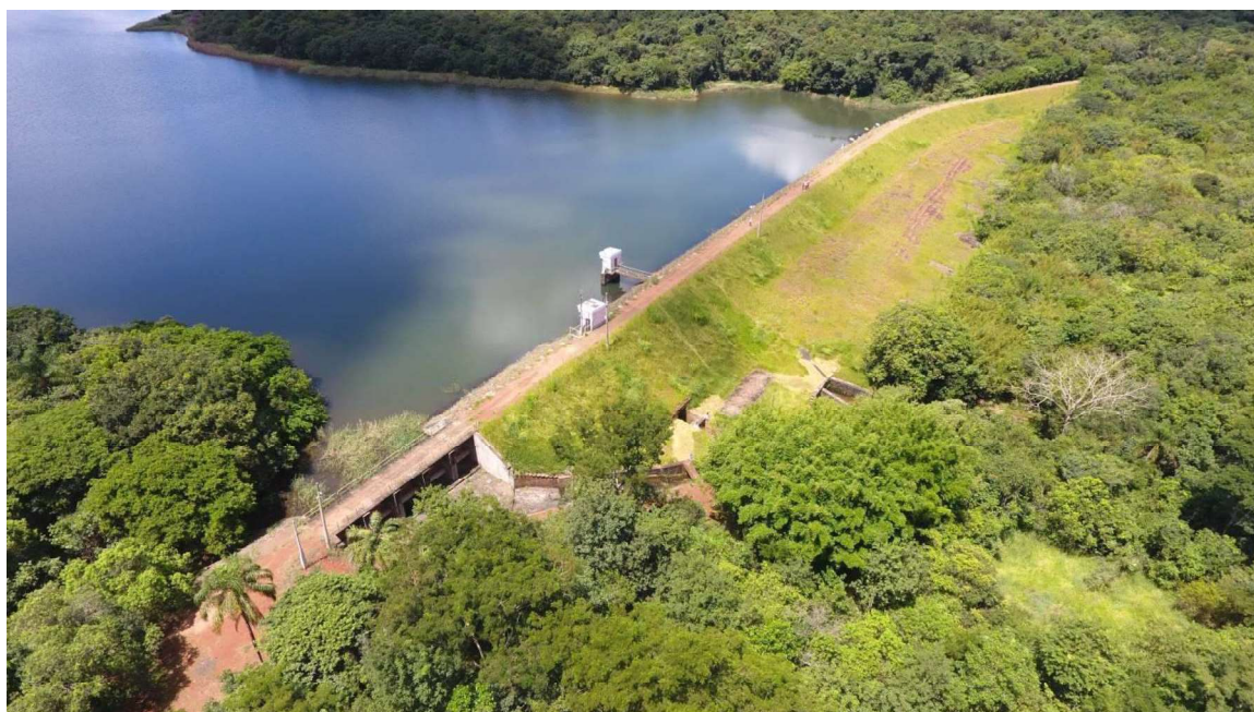
Figura 5. Barragem do Retiro
