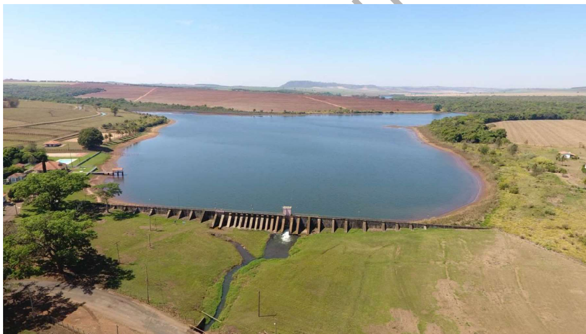
Figura 2. Vista geral da barragem da Barra
