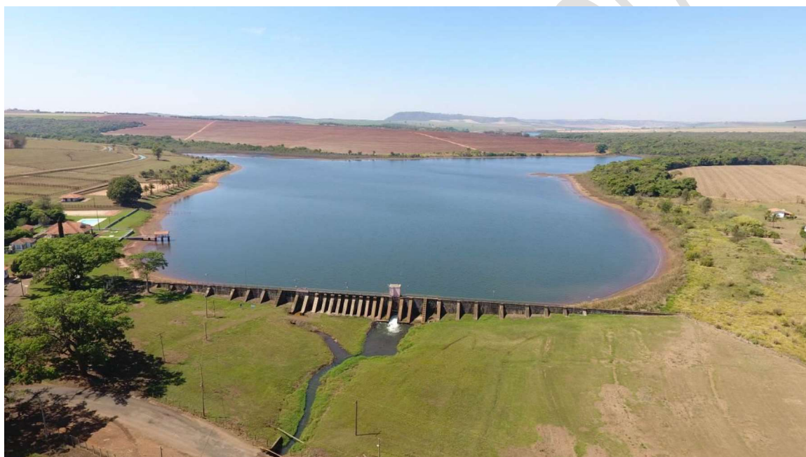
Figura 2. Vista geral da barragem da Barra
