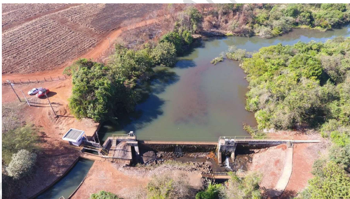
Figura 4. Vista geral da barragem do Alegria
