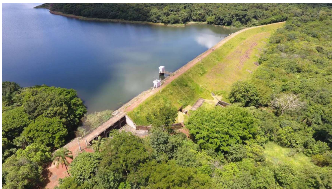
Figura 5. Barragem do Retiro
