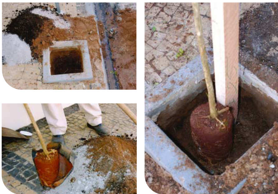
Abertura de cova com o preparo do substrato, retirada de embalagem e colocação da muda e da estaca no "berço".
