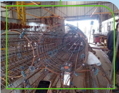
Armadura de aço como condutor integrado
