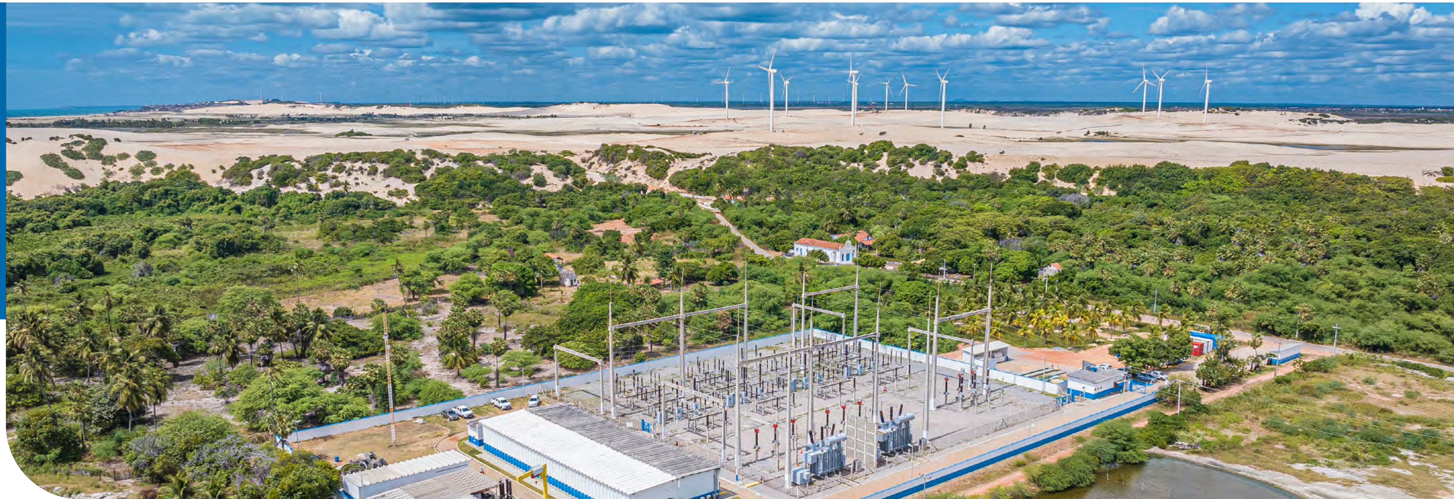
Complexo Eólico de Aracati, no Ceará.
