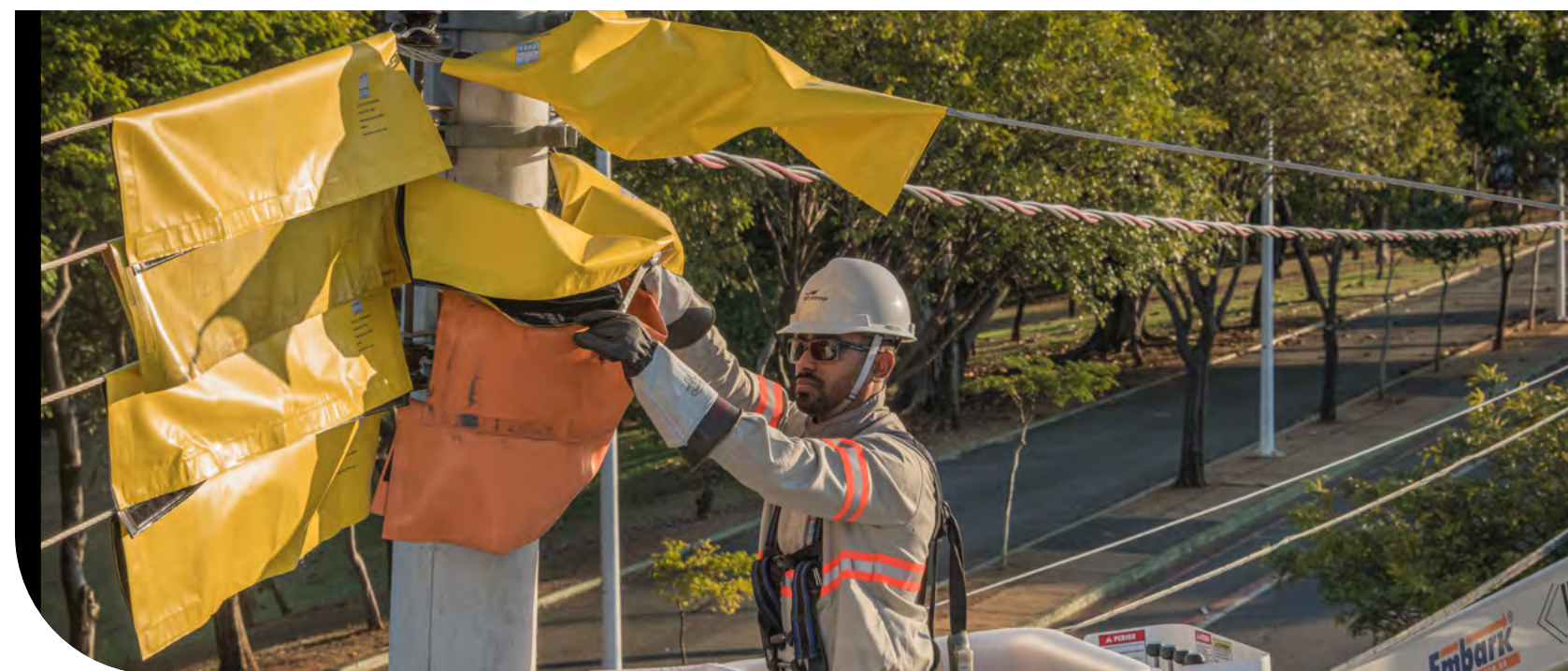
Manutenção em rede da CPFL Piratininga (SP).
