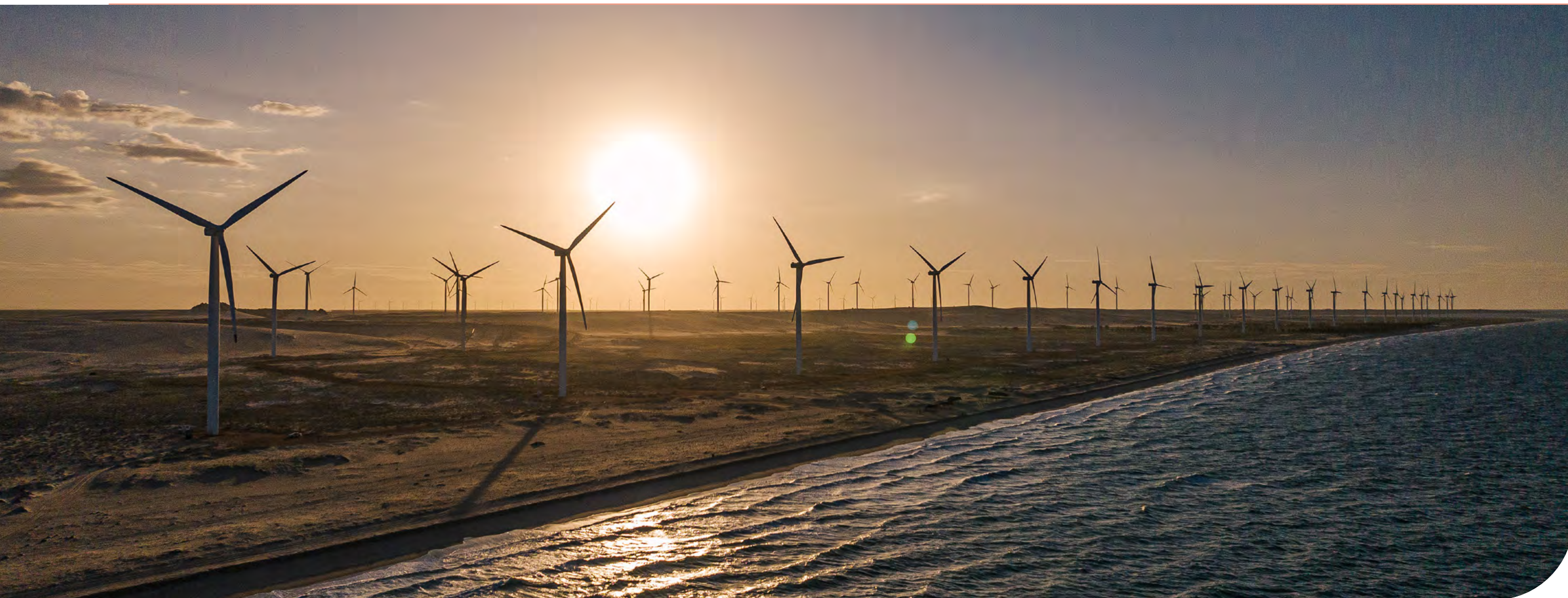
Complexo Eólico de Aracati, no Ceará.
