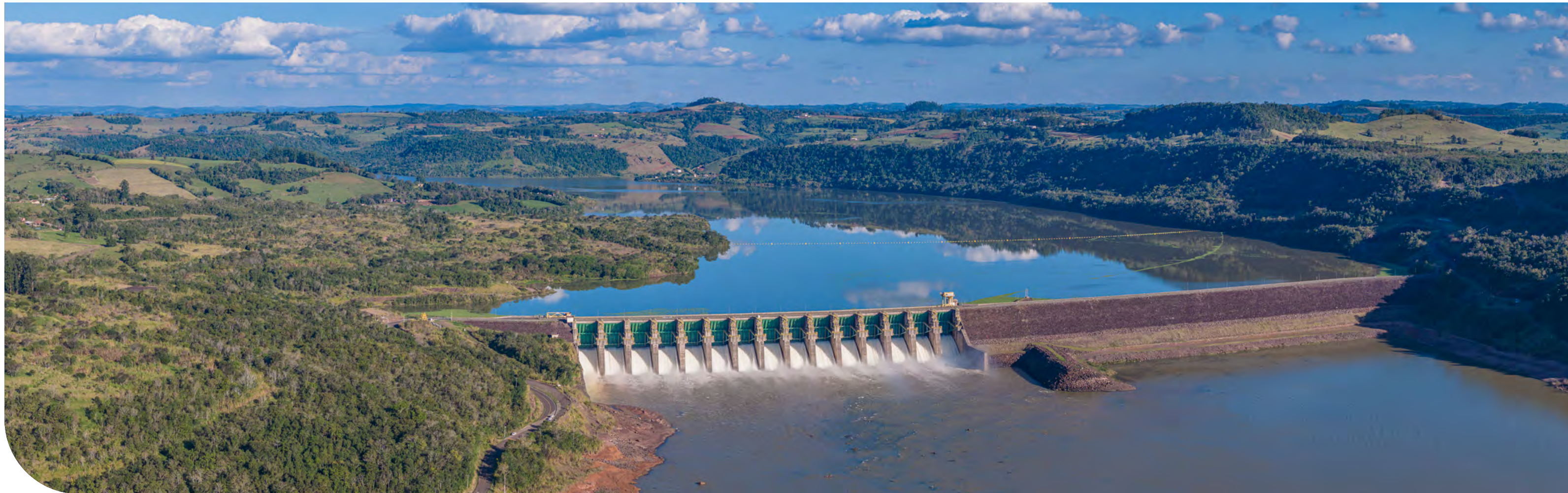
Usina hidrelétrica Foz do Chapecó, em Santa Catarina.
