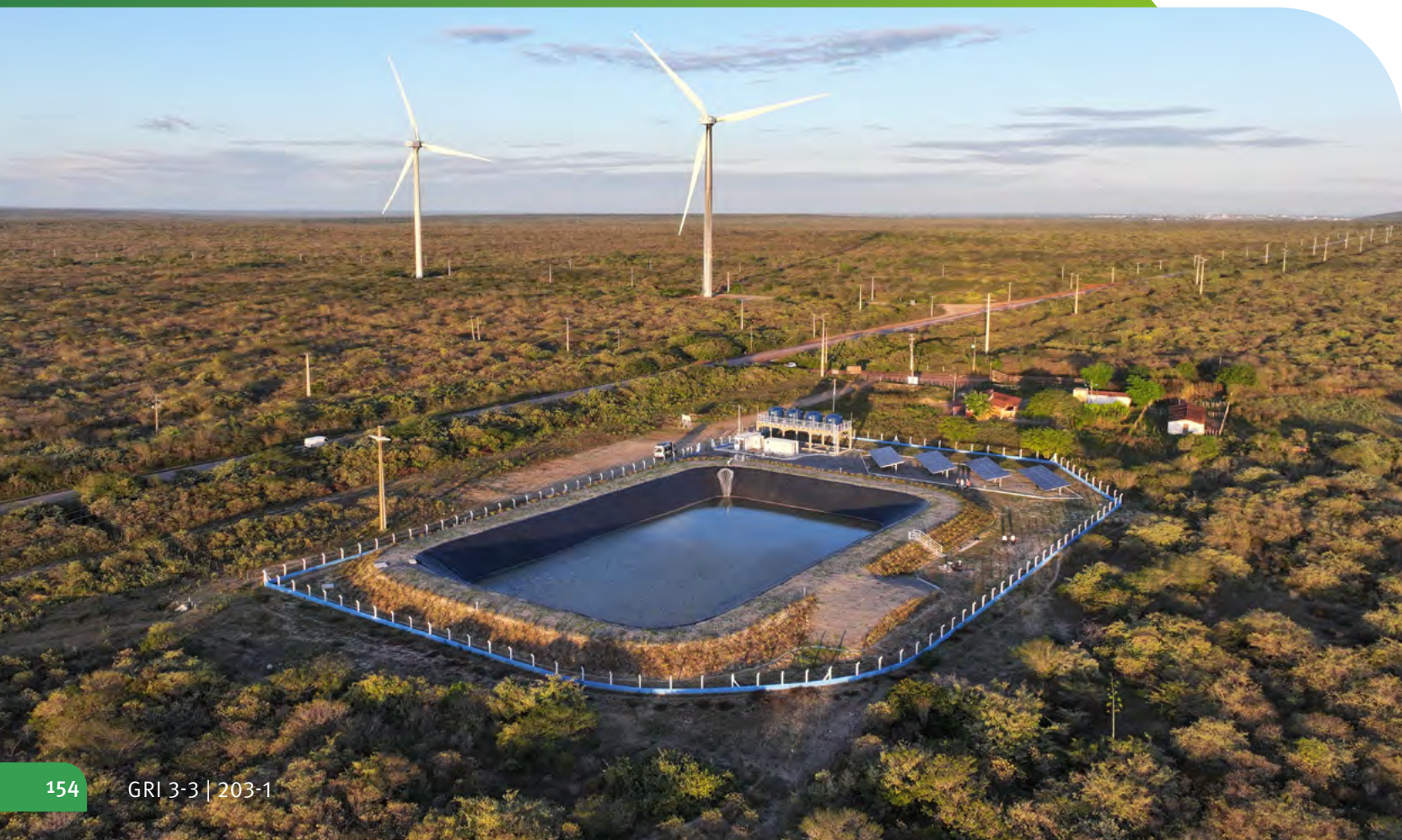
Planta de dessalinização de água construída no interior do Rio Grande do Norte.
