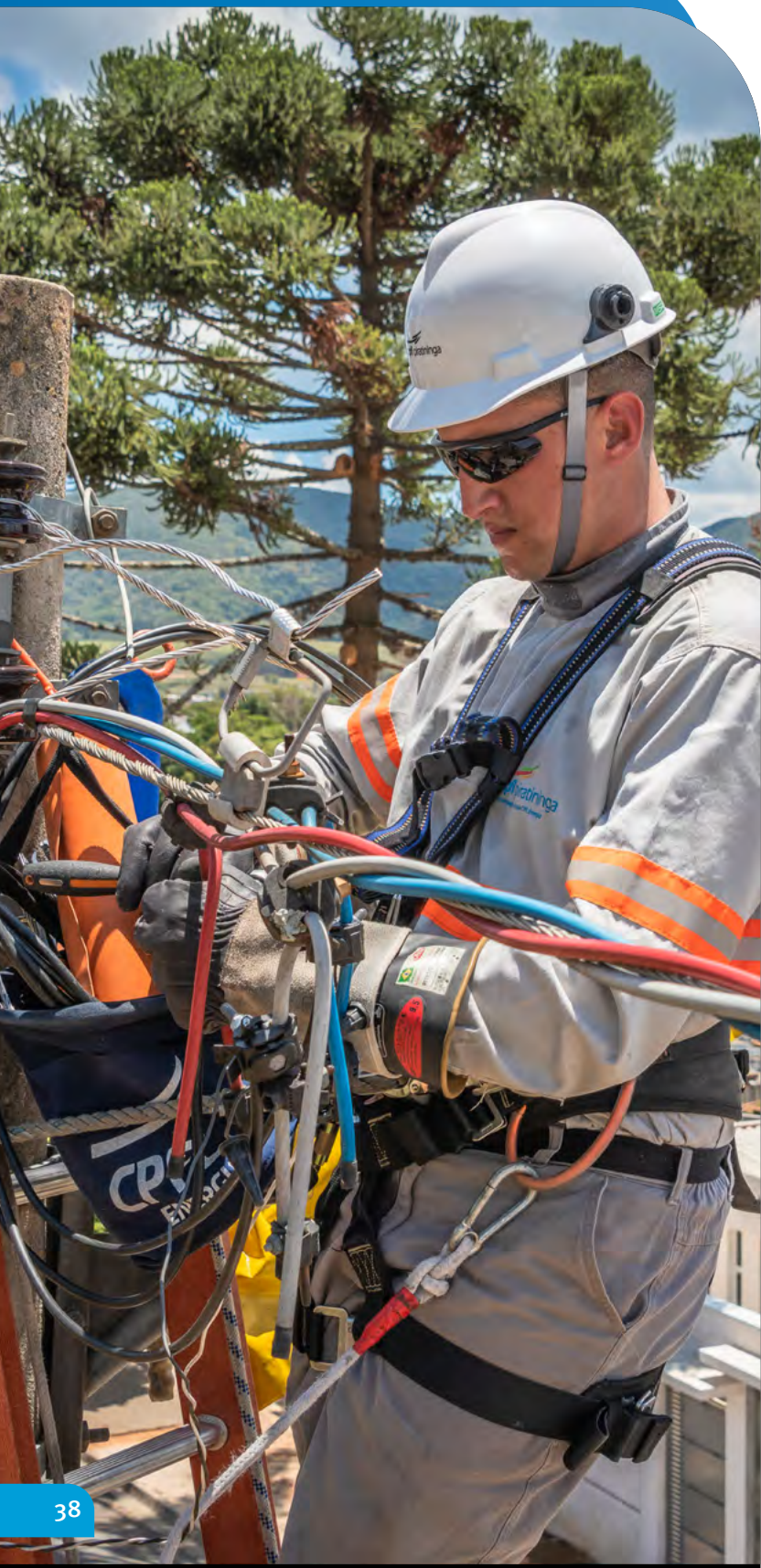
Manutenção em rede da CPFL Piratininga (SP).
