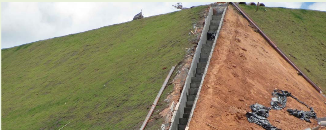
Figura 4.9.5.1.2-1: Escada d'água ou dissipador de energia.
