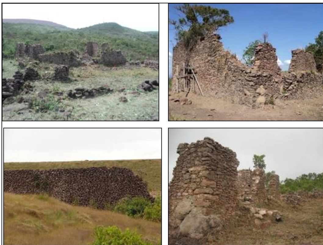
Figura 2. Exemplos de remanescentes das edificações que compõem a área nuclear do Arraial de São Francisco Xavier da Chapada (ZANETTINI ARQUEOLOGIA, 2011).
