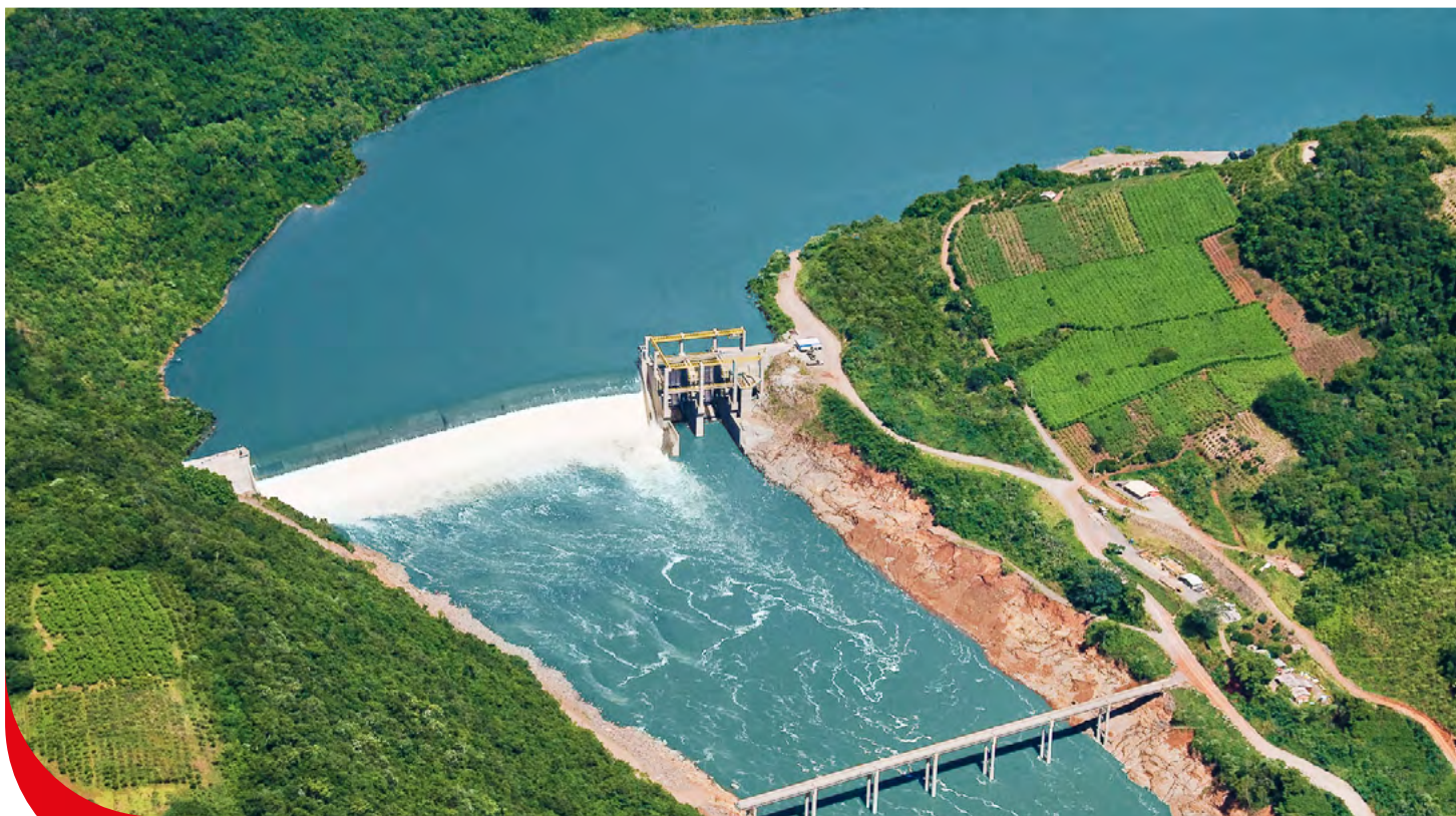
Usina Hidrelétrica 14 de Julho (CERAN)
