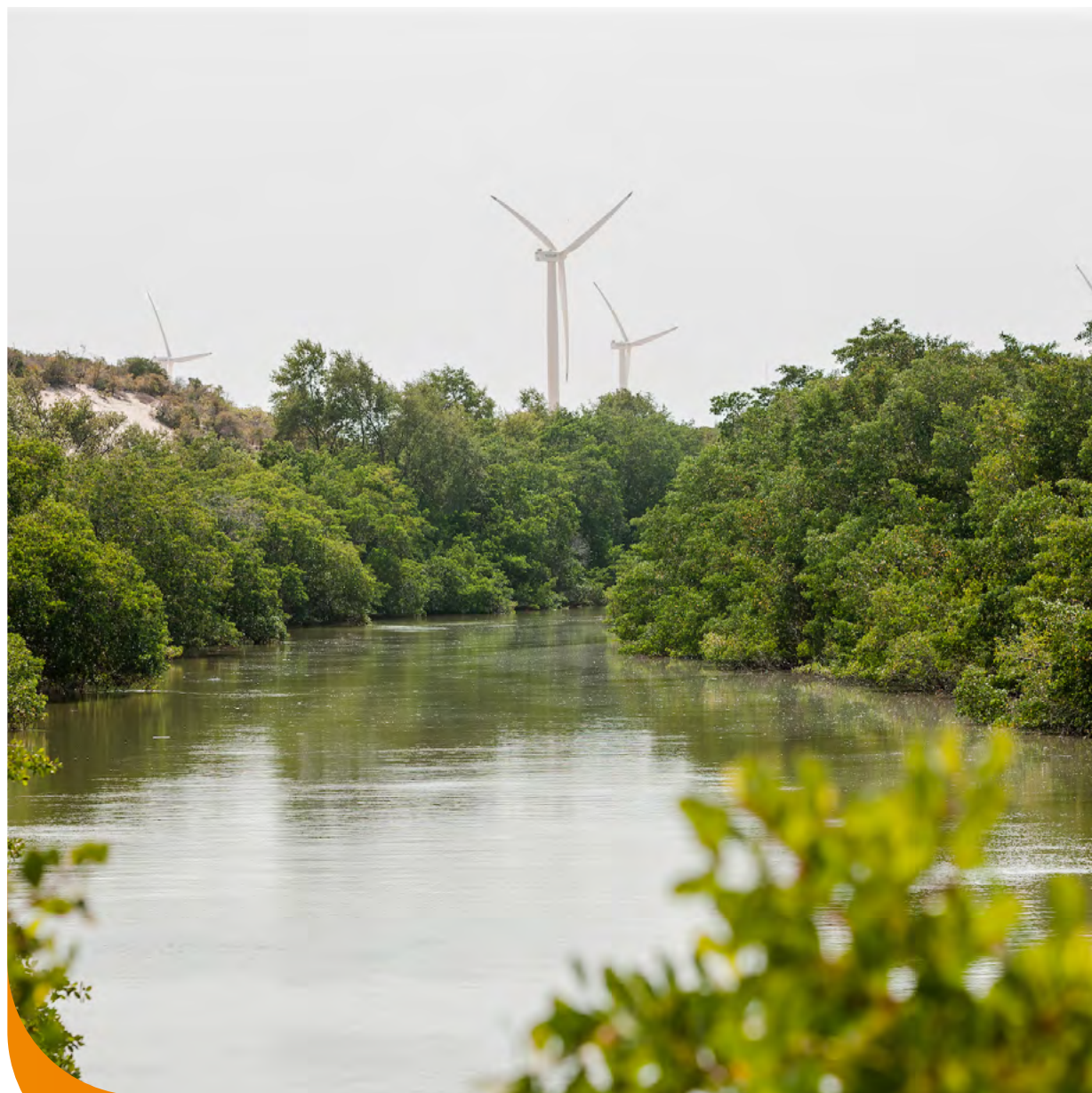
Usina Eólica da CPFL Renováveis no Ceará
