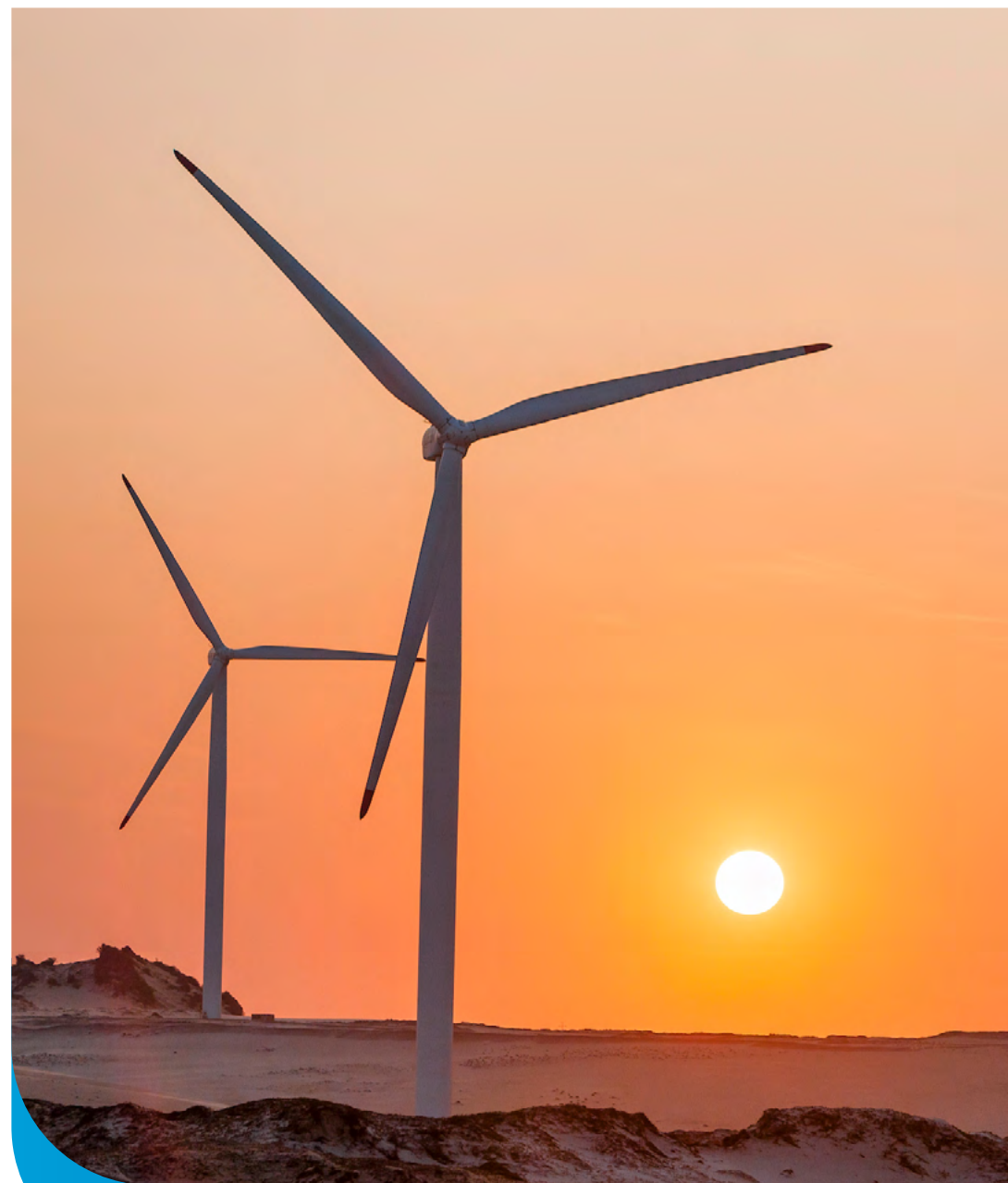
Parque Eólico da CPFL Renováveis no Ceará
