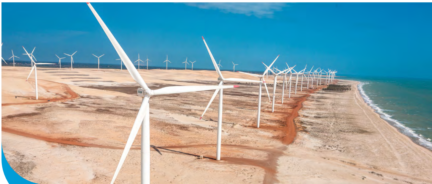
Parque Eólico da CPFL Renováveis no Ceará
