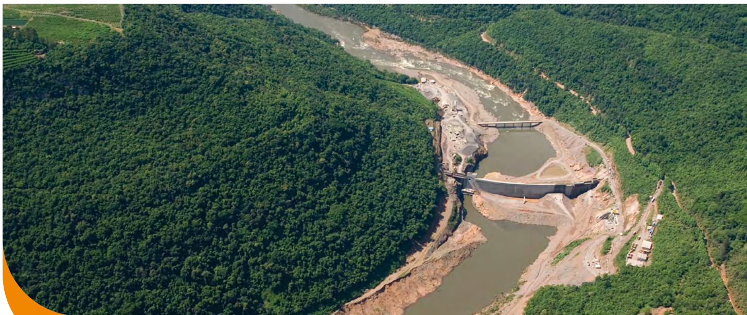
Usina Hidrelétrica Castro Alves (Ceran)
