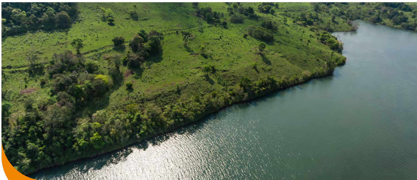
Represa Usina Hidrelétrica Foz de Chapecó
