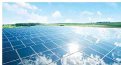
A geração fotovoltaica é uma tecnologia mais antiga e mais difundida, que, por meio da incidência da **luz solar** sobre painéis dotados de células fotovoltaicas à base de silício cristalino, produz eletricidade por meio de um processo semelhante ao das pilhas.
