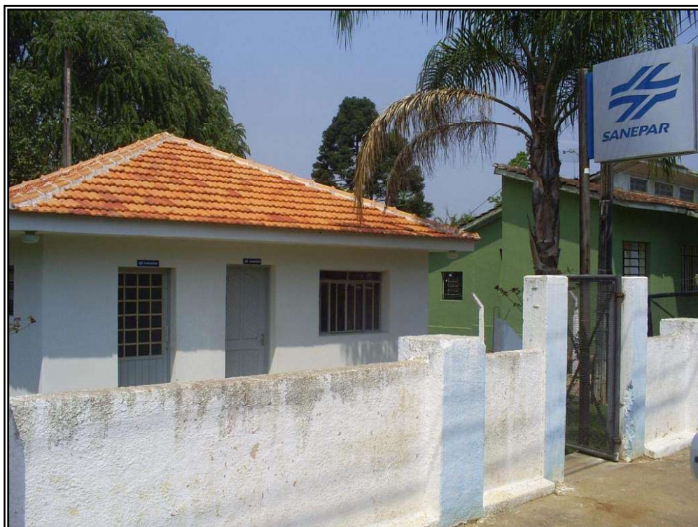
Figura 59 – Unidade da SANEPAR implantada no município de Porto Amazonas.
