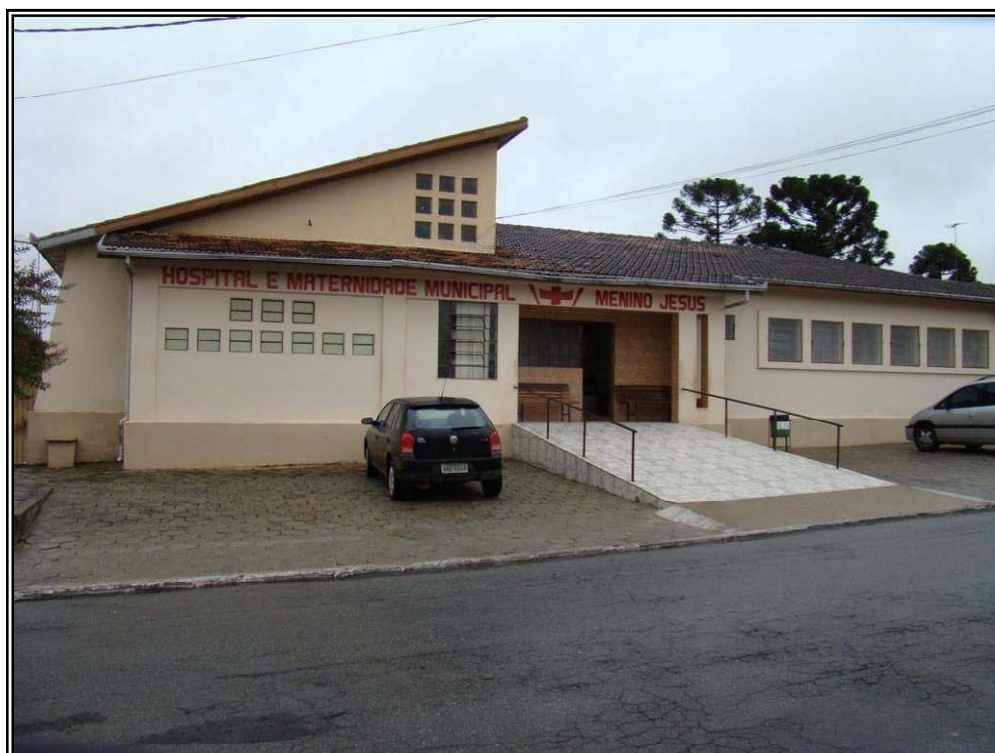
Figura 64 – Hospital e Maternidade Menino Jesus, localizado na área central do município de Porto Amazonas.
