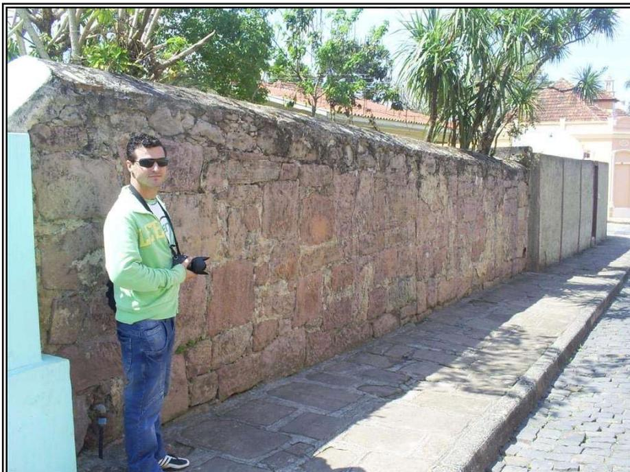
**Figura 14** – Muro de arenito avermelhado - compatível com os litotipos da formação Furnas - em residência do município de Lapa.
