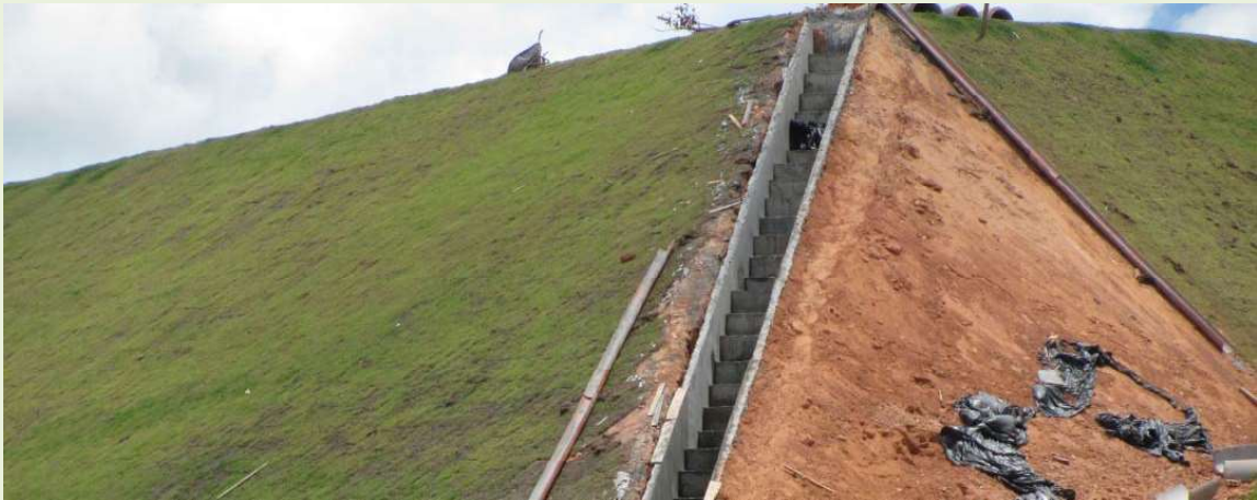
Figura 4.9.5.1.2-1: Escada d'água ou dissipador de energia.
