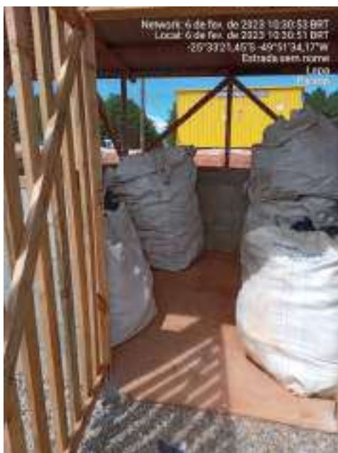
Figura 03 – Baia de resíduos
