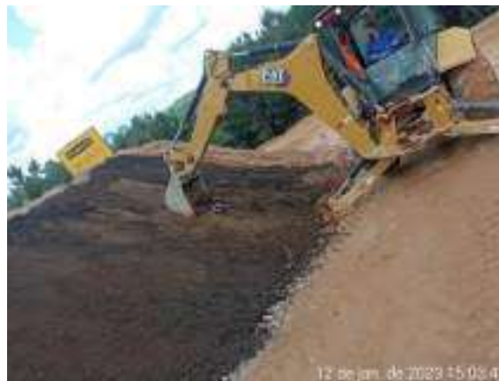
Figura 20 – Conformação de talude
