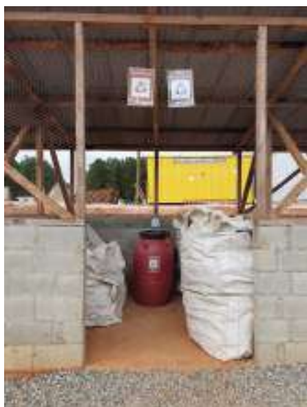
Figura 03 – Baia de resíduos
