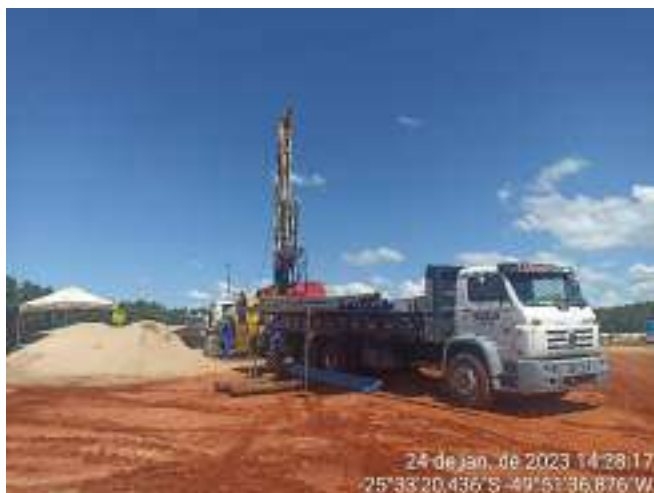
Figura 11 – Perfuração do poço do canteiro de obras
