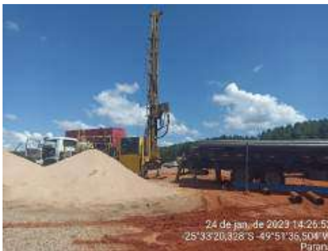
Figura 12 – Perfuração do poço do canteiro de obras
