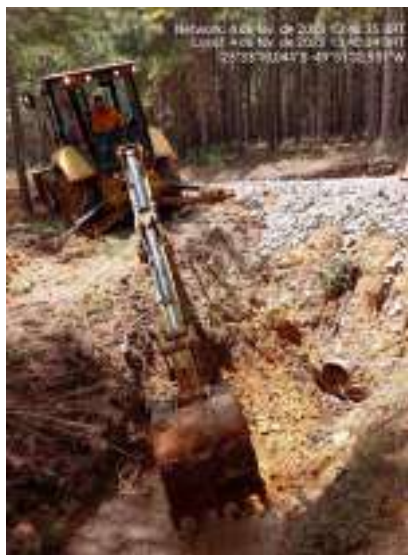
Figura 19 – Manutenção de bueiros
