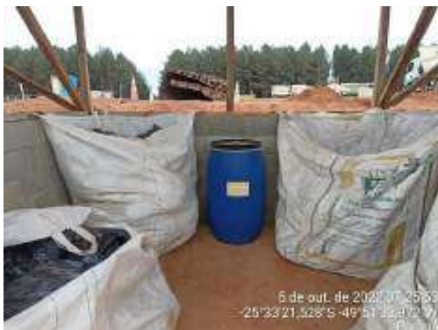
Figura 03 – Baia de resíduos não recicláveis
