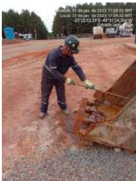
Figura 41 – Acompanhamento de foco de acúmulo de água
