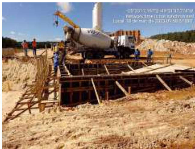
Figura 16 – Construção decantador da central
