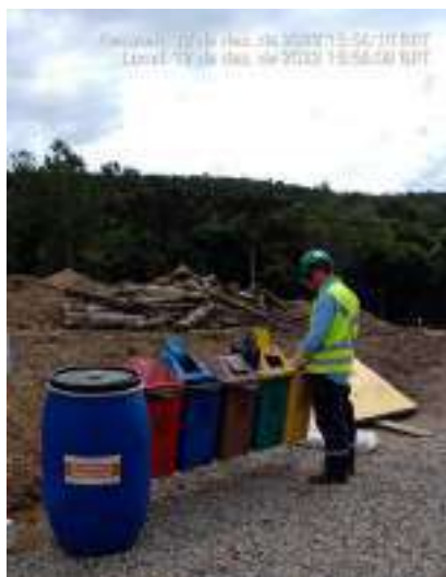
Figura 01 – Coletores disponibilizados nas frentes de serviço
