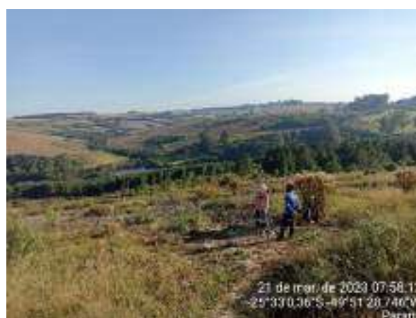
Figura 46 – Atividade de marcação topográfica
