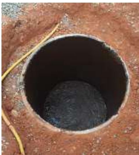
Figura 05 – Impermeabilização de caixa coletora
