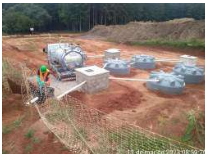
Figura 12 – Coleta e limpeza da caixa gradeada
