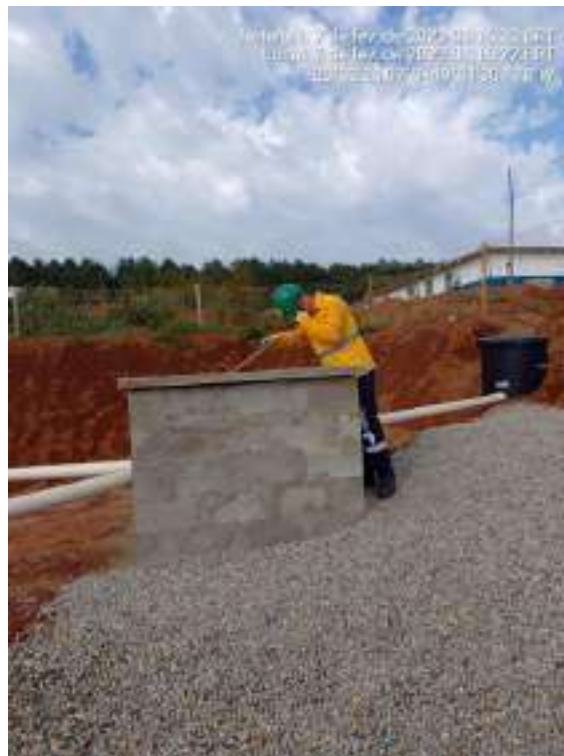
Figura 08 – Inspeção de ECP
