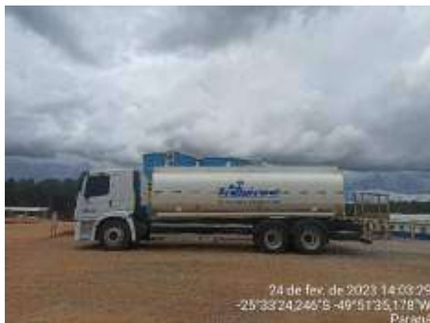
Figura 15 – Abastecimento de água do canteiro
