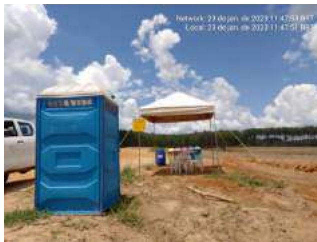
Figura 06 – Controle de limpeza dos banheiros
