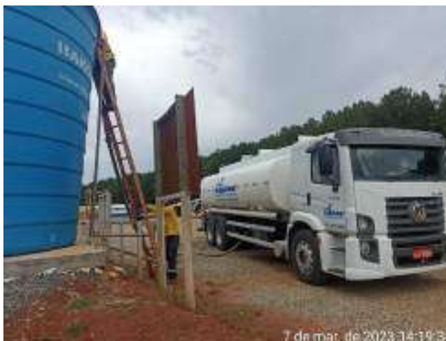
Figura 20 – Abastecimento de água do canteiro
