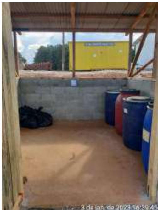
Figura 03 – Baia de resíduos
