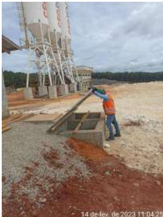
Figura 07 – Inspeção de ECP
