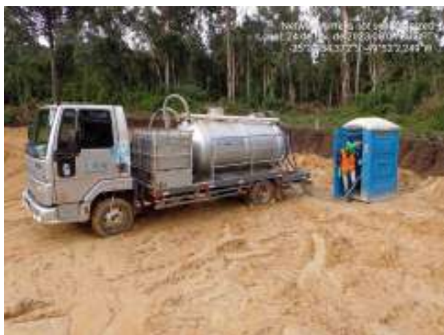
Figura 05 – Controle de limpeza dos banheiros
