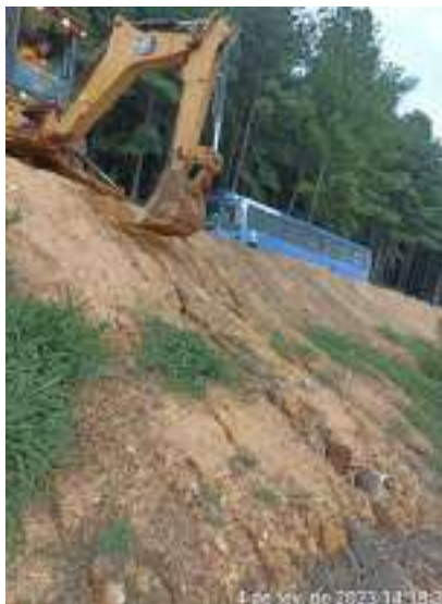
Figura 20 – Correção de processos erosivos
