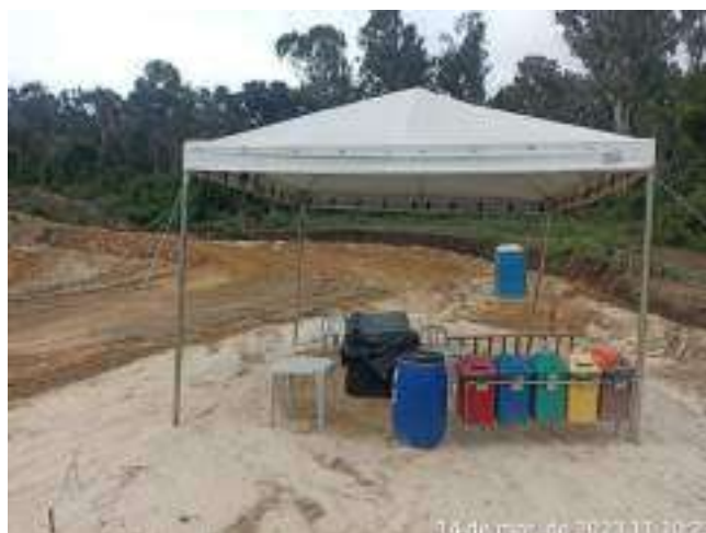
Figura 02 – Coletores disponibilizados nas frentes de serviço
