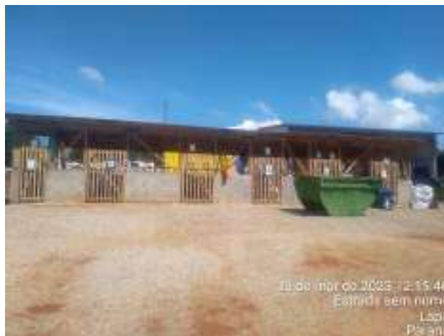
Figura 04 – Baia de resíduos
