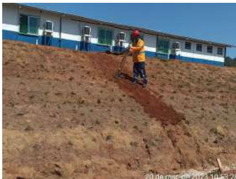
Figura 24 – Correção de processos erosivos
