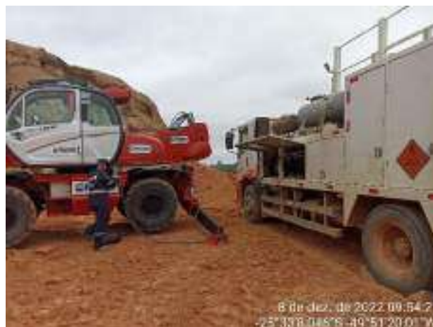
Figura 30 – Abastecimento de máquinas e equipamentos
