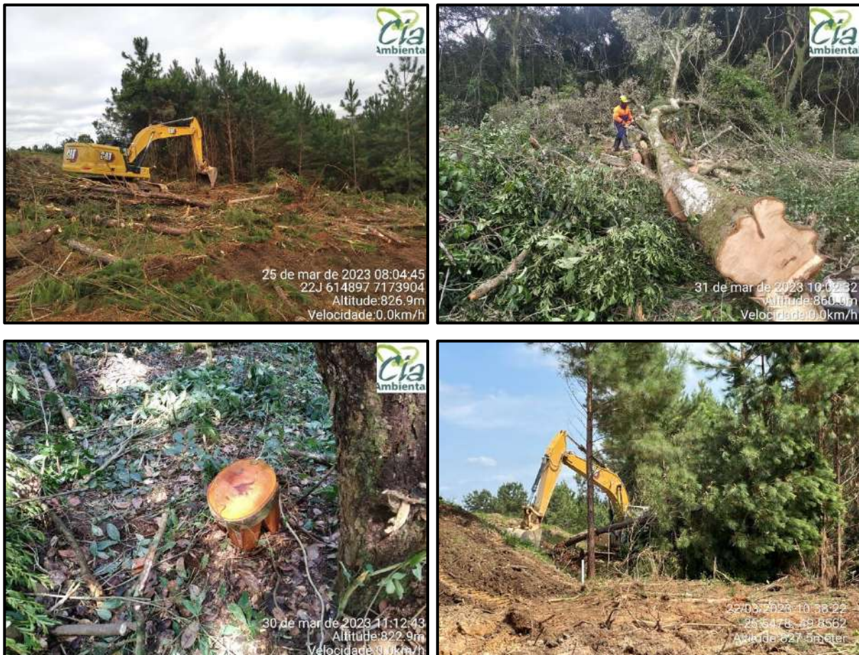
Figura 46 – Execução das atividades de supressão vegetal no canal de drenagem e bota-fora 02.
