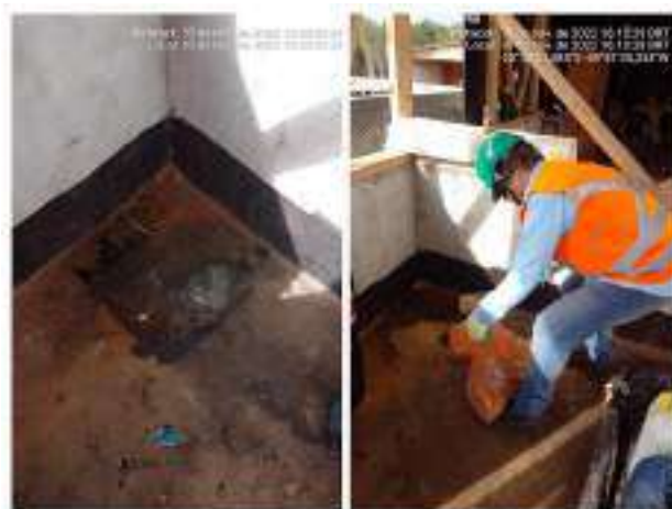
Figura 14 – Mitigação Ambiental na oficina
