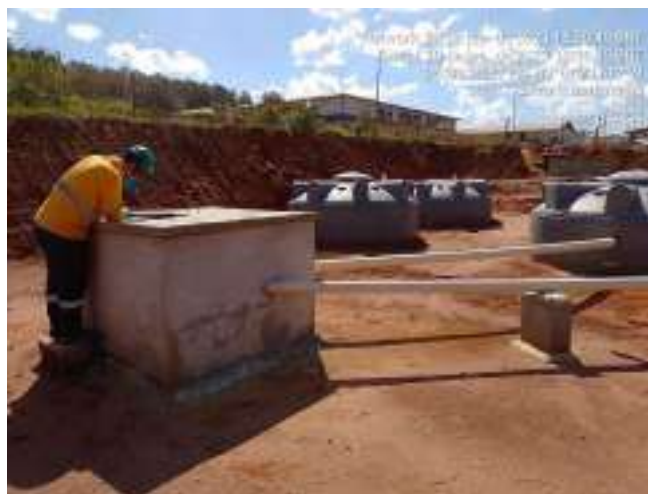
Figura 08 – Inspeção do sistema SAO
