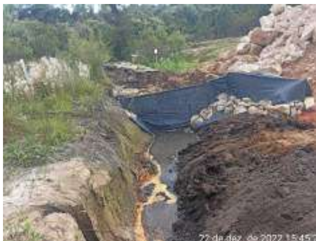
Figura 15 – Contenção provisória em manta
