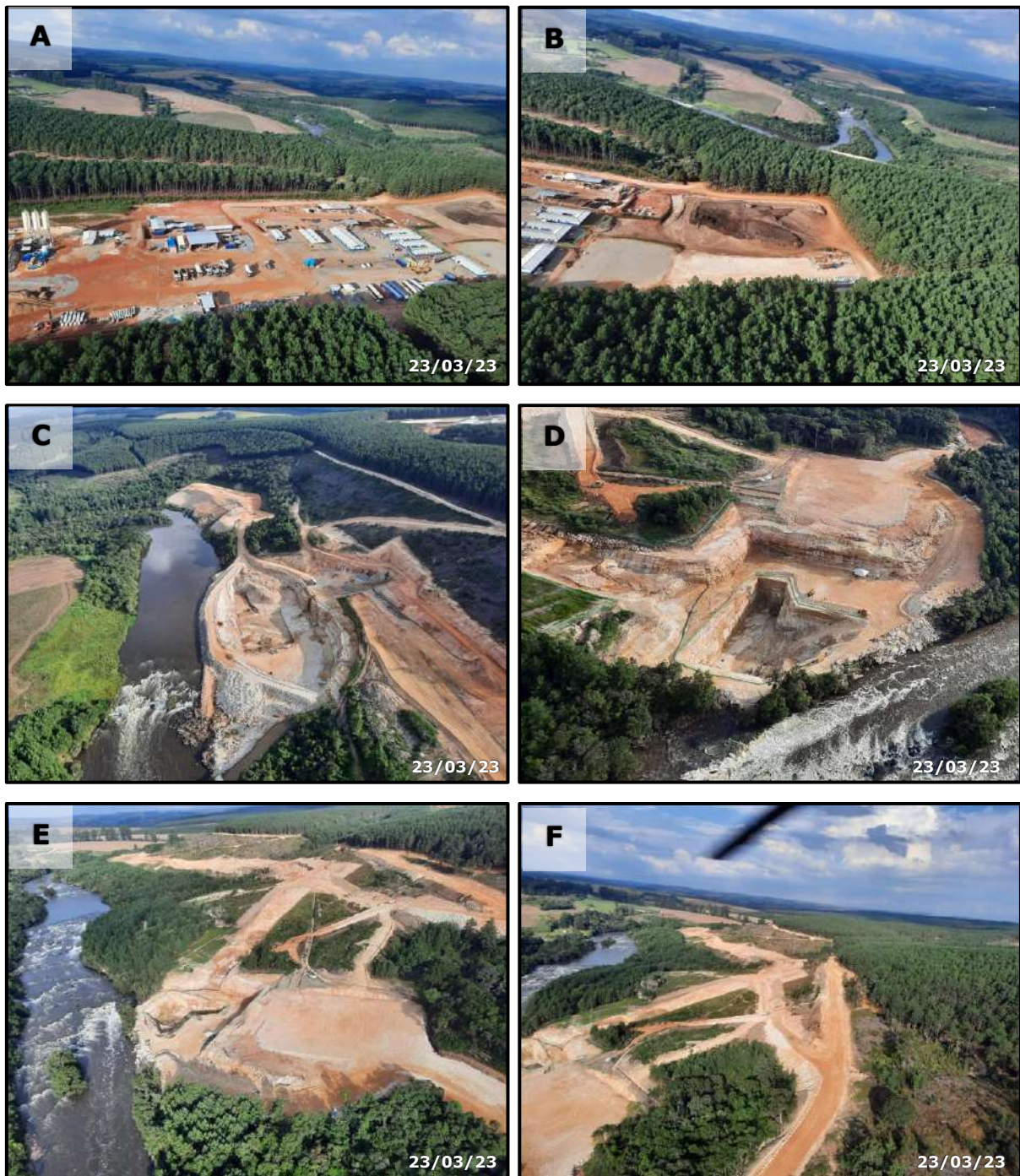
Figura 2 – Registros fotográficos do canteiro de obras e estruturas da PCH.
