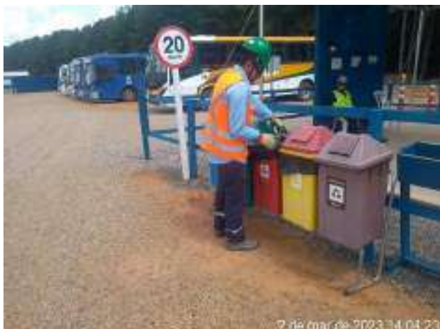
Figura 03 – Coleta dos resíduos nas frentes de serviço
