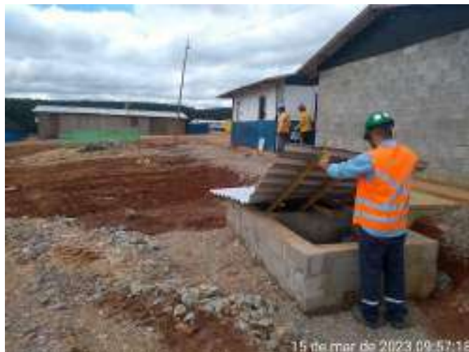
Figura 10 – Inspeção em ECP
