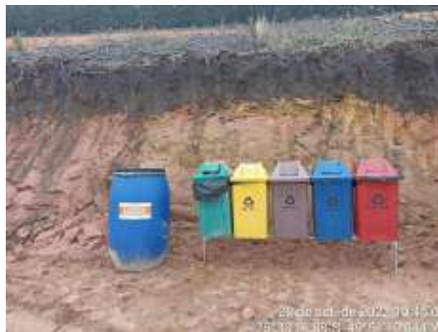
Figura 02 – Coletores disponibilizados nas frentes de serviço
