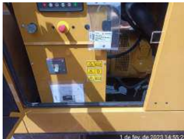
Figura 38 – Atividade equipe de manutenção
