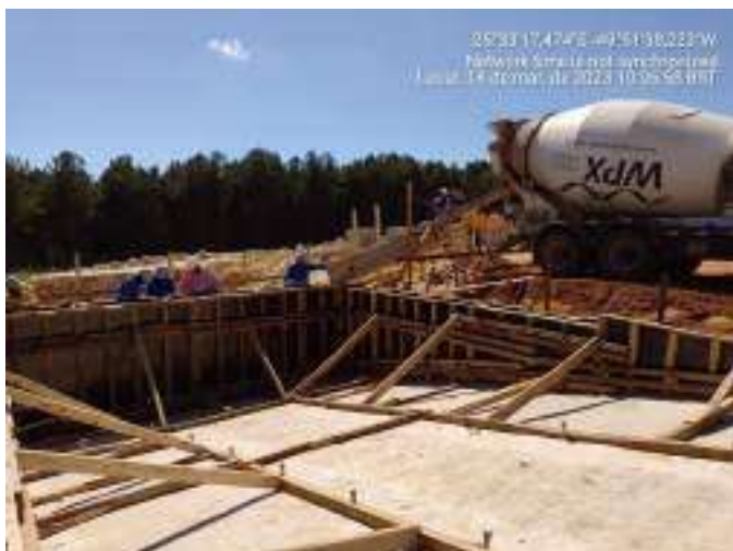
Figura 15 – Construção decantador da central
