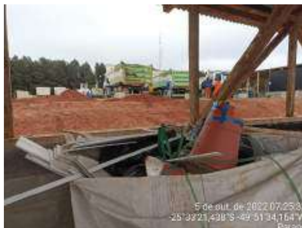
Figura 04 – Bigbags para separação dos resíduos
