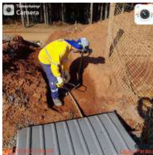
Figura 06 – Instalação e manutenção de caixa SAO
