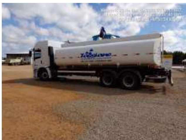
Figura 13 – Abastecimento de água do canteiro
