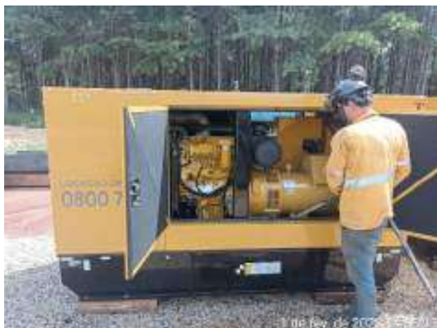
Figura 37 – Atividade equipe de manutenção
