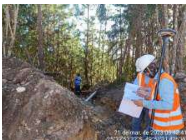
Figura 45 – Atividade de marcação topográfica
