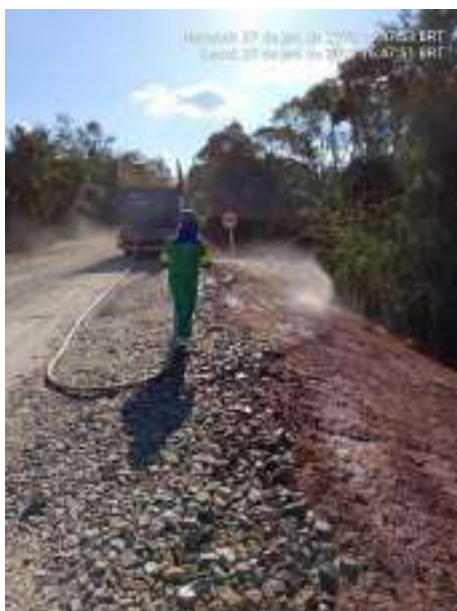
Figura 21 – Atividade de hidrossemeadura
