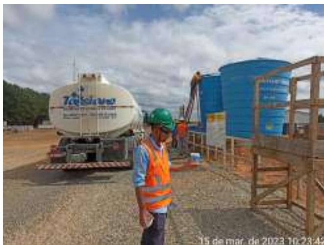
Figura 19 – Abastecimento de água do canteiro
