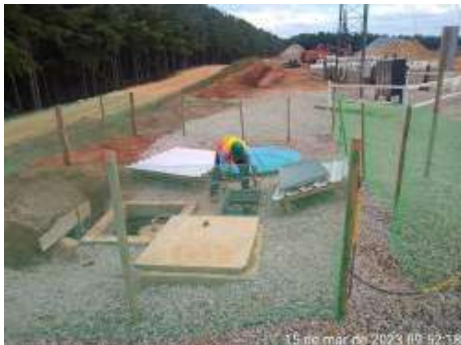
Figura 09 – Inspeção em ECP
