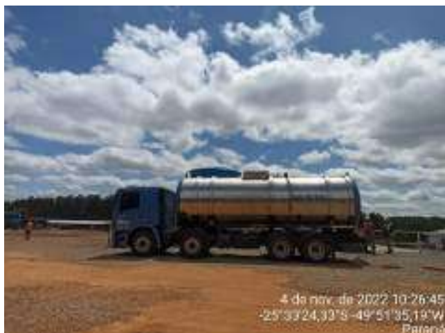
Figura 09 – Abastecimento de água do canteiro
