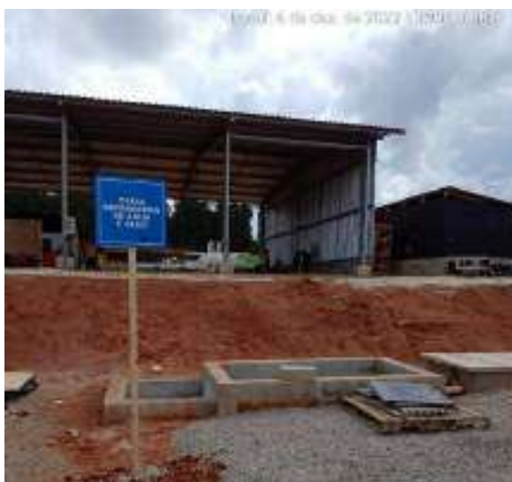
Figura 07 – Construção de melhorias no sistema SAO
