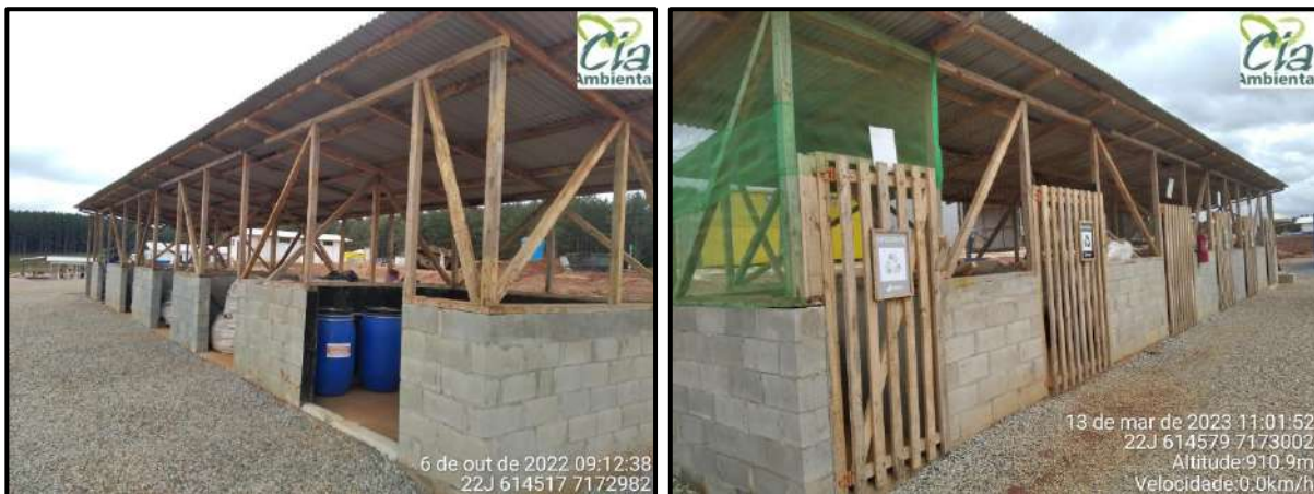
Figura 12 - Registros fotográficos da baia de resíduos sólidos central.
