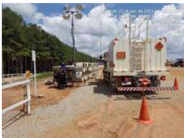
Figura 37 – Abastecimento de máquinas e equipamentos
