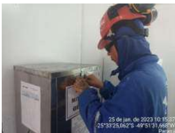
Figura 17 – Limpeza e lacre dos bebedouros
