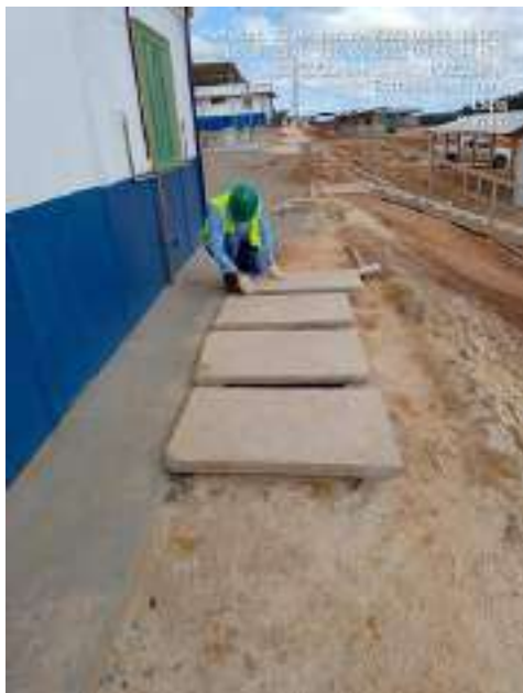
Figura 09 – Inspeção no ECP do refeitório
