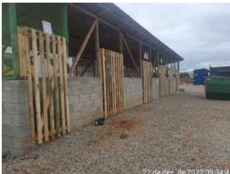
Figura 04 – Baia de resíduos
