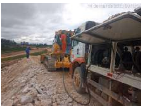
Figura 39 – Abastecimento de máquinas e equipamentos
