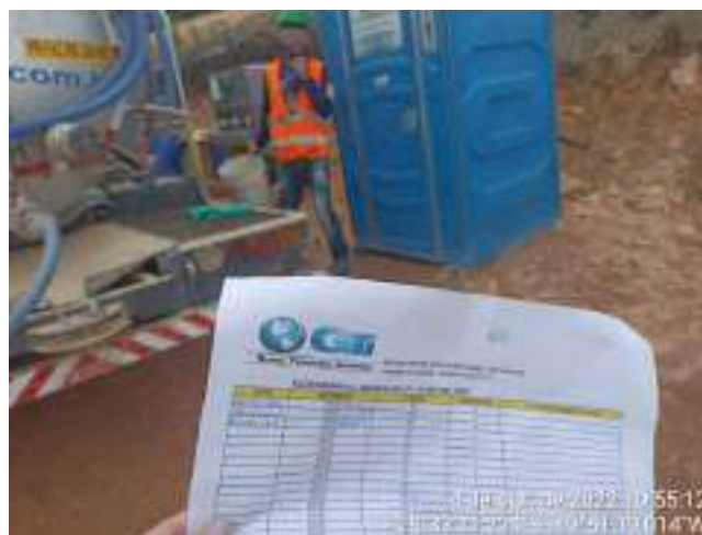
Figura 08 – Controle de limpeza dos banheiros
