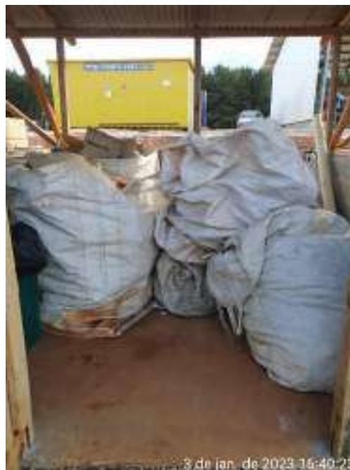
Figura 04 – Baia de resíduos
