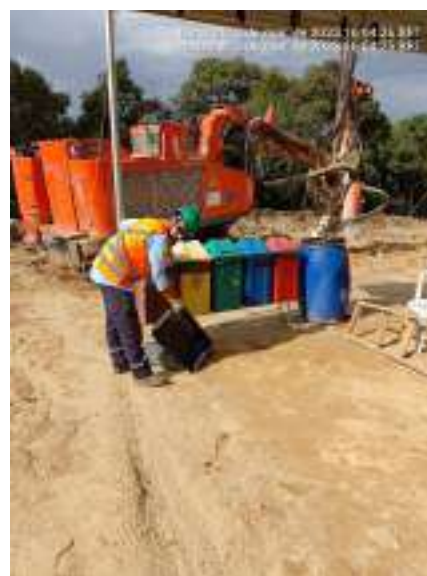
Figura 06 – Coleta dos resíduos nas frentes de serviço
