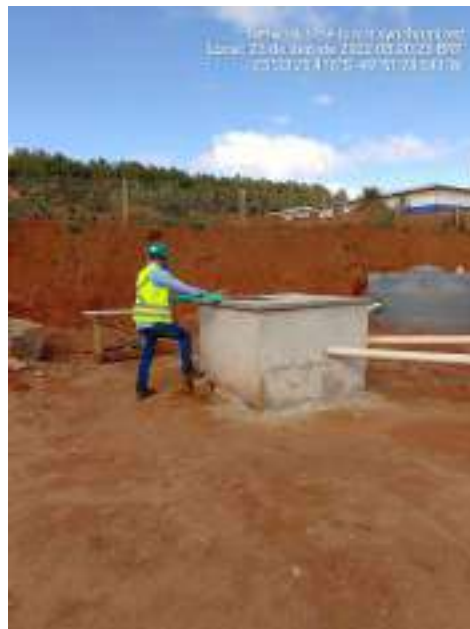
Figura 10 – Inspeção no Sistema de Tratamento de Efluente
