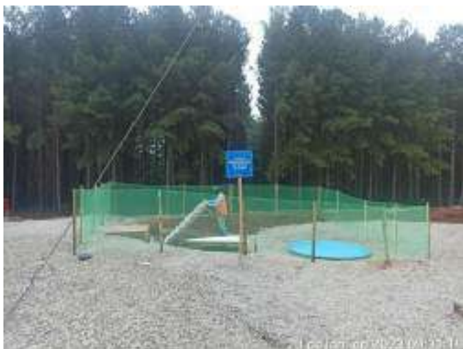
Figura 07 – Inspeção do sistema SAO
