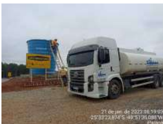
Figura 15 – Abastecimento de água do canteiro
