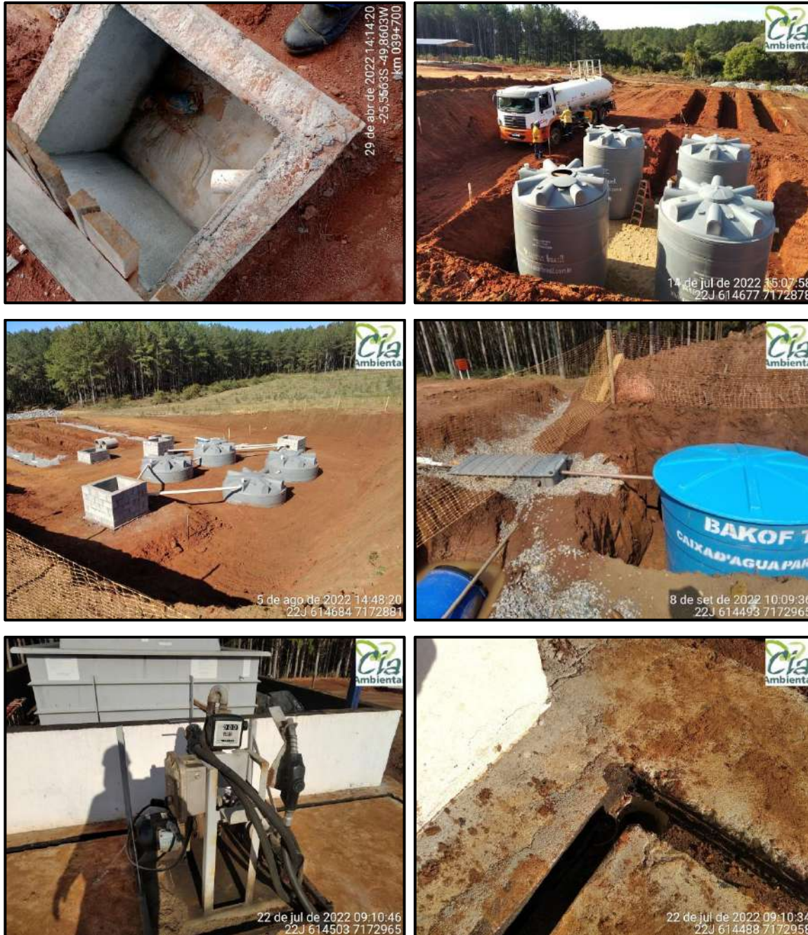
Figura 12 – Inspeções realizadas durante a instalação dos sistemas de controle de poluição.
