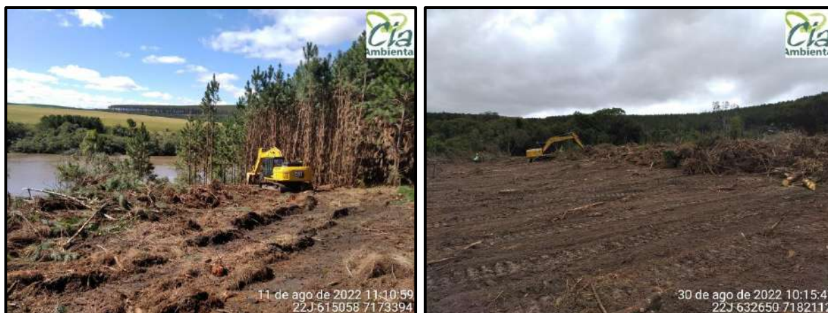
Figura 21 - Atividades de supressão vegetal, decapagem e destoca nas áreas das superestruturas da PCH Cherobim.
