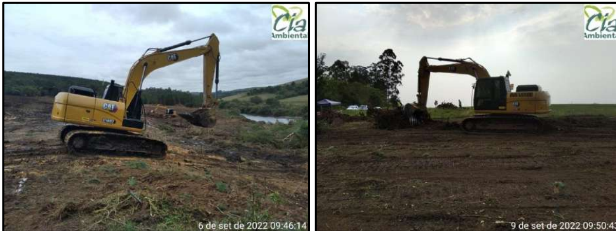
Figura 23 - Separação do material lenhoso suprimido.
