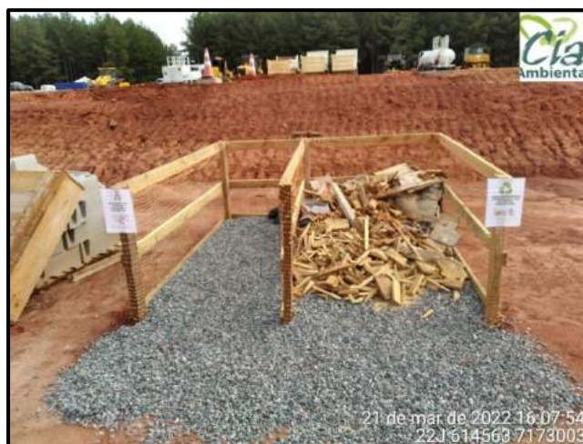
Figura 4 – Baia provisória para armazenamento dos resíduos recicláveis e não recicláveis gerados na implantação do canteiro de obra da PCH.
